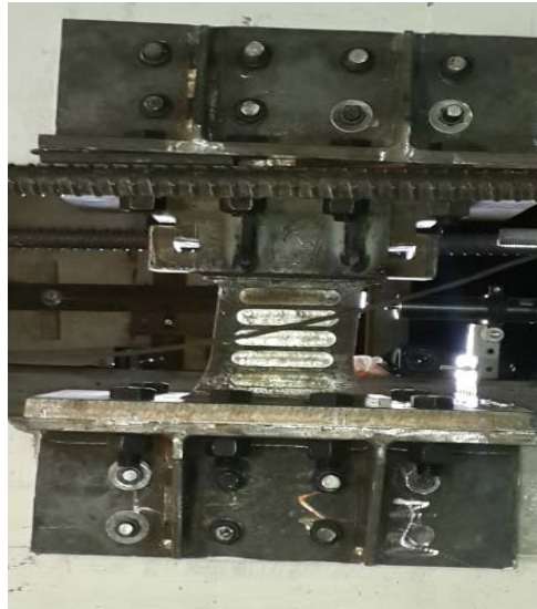
Fig. 2.28 Deformación lateral del disipador tipo 2
