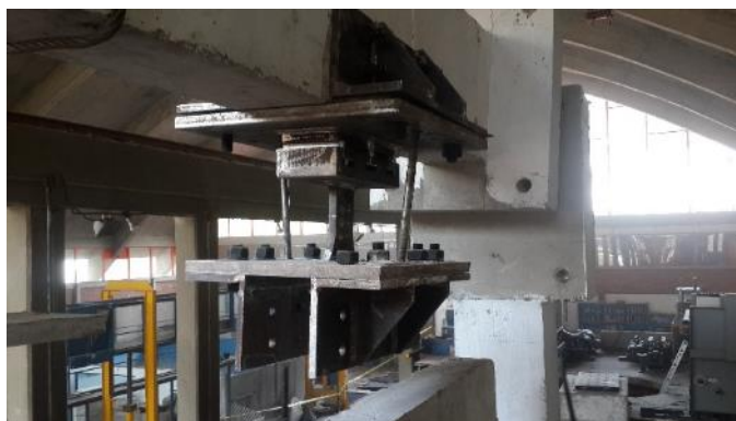
Fig. 2.17 Colocación del disipador tipo 1
