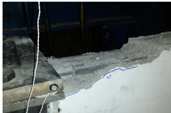
Fig. 2.32 Falla del muro en la conexión del lado derecho.
