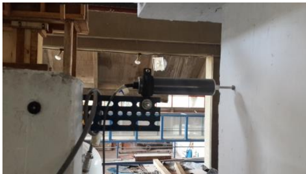
Fig. 2.8 Colocación de transductor 4
