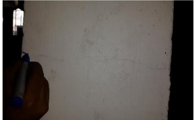
Fig. 2.25 Fisura en la base de la columna Fig.2.26 Fisura en la parte media dela columna
