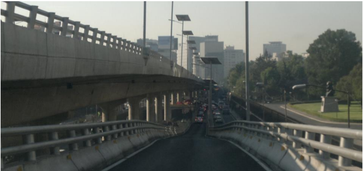
Figura 17. Vista de la rampa de salida "Hospital" y lateral de periférico.
