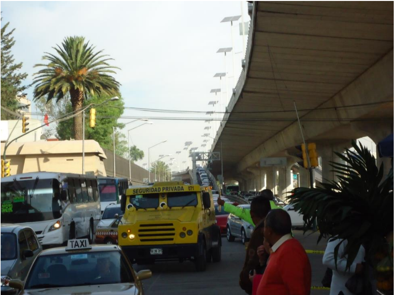
Figura 9. Salida “Hospital Militar” Vista del congestionamiento de la rampa.
