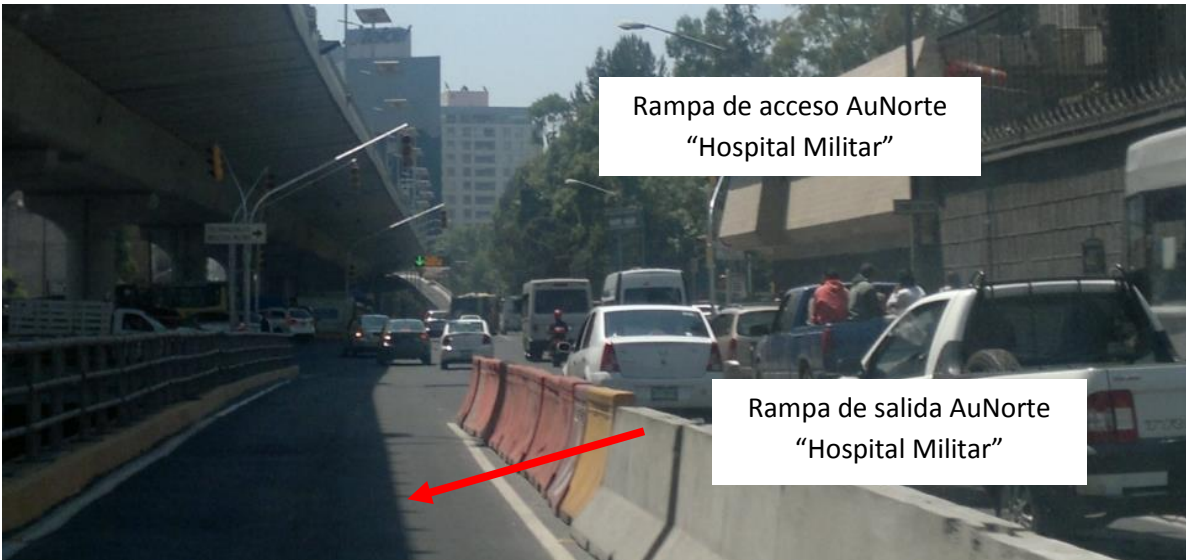
Figura 16. Vista de las rampas de entrada y salida “Hospital Militar”
