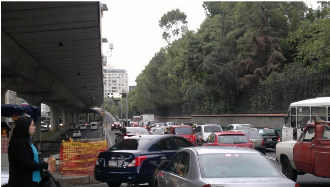
Figura 6. Retorno hacia la rampa de acceso "Hospital Militar" Vista de la lateral y de la invasión del carril de acceso a la rampa.
