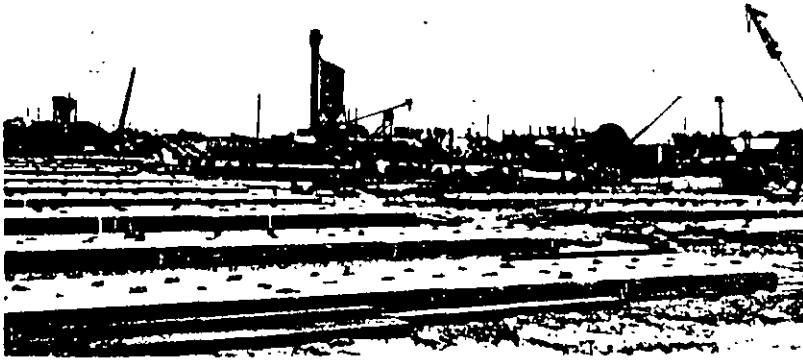
Fig. 10-5—El pronto recubrimiento con lonas que siempre se mantienen empapadas, protege el hormigón durante su curado en clima cálido.
