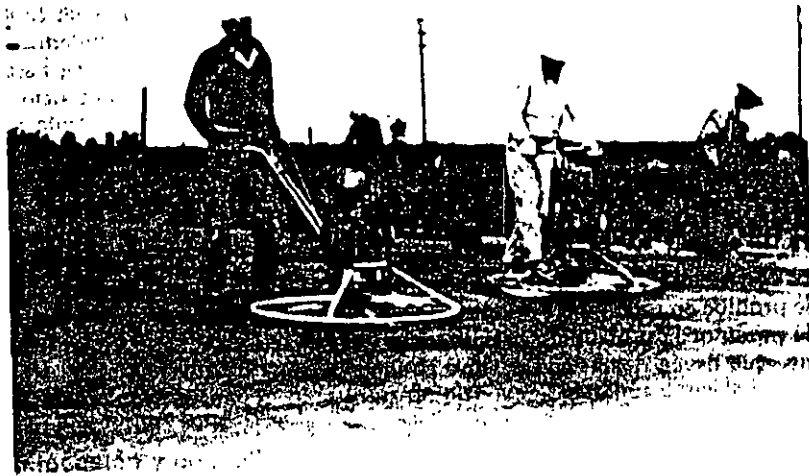
Fig. 12-2—Máquinas terminadoras, que alisan y pulen la superficie de una losa de hormigón.
