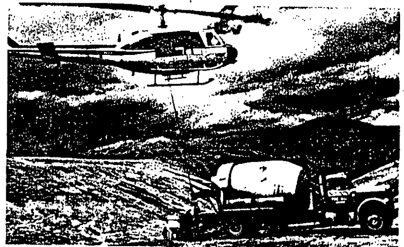
Fig. 9-2—Camión-hormigonero que descarga hormigón en un cubo para que el helicóptero lo lleve por aire a un sitio de construcción en deshabitado.
