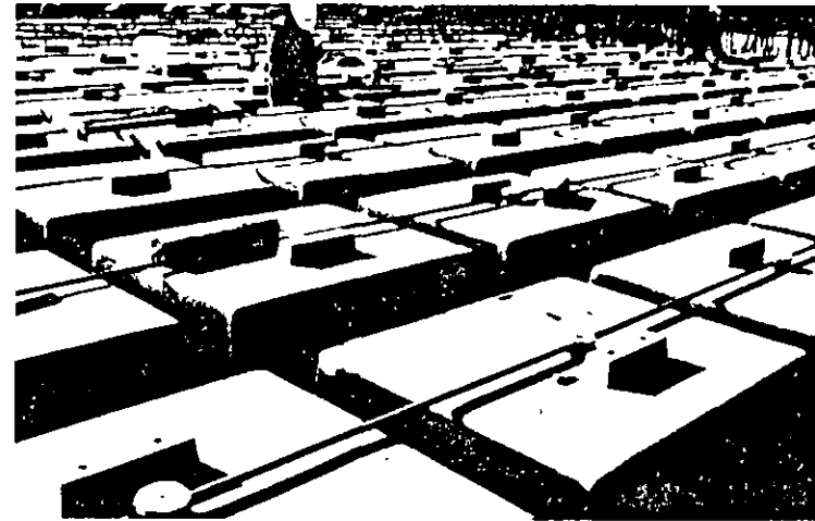
Fig. 14-6—Reparación de imperfecciones en la superficie de la formaleta, con el fin de lograr bovedillas intachables para el cielo raso cuando se vacie esta losa armada en dos direcciones.
