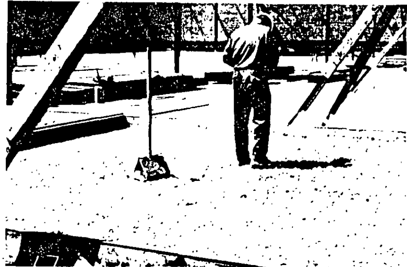
Fig. 14-9—Hay un método con el cual se obtiene una superficie de agregado expuesto en panel de pared prefabricado de voltear, consistente en extender una capa de agregado sobre lecho de arena, apisonándola para que el material quede embebido y fijo en la arena, en vaciar luego el hormigón sobre el agregado. Algunas veces, antes de vaciar el hormigón, se le da una lechada al agregado para mantenerlo en su sitio. Se levanta el panel, una vez curado, y se lava la arena que haya quedado adherida allí.
