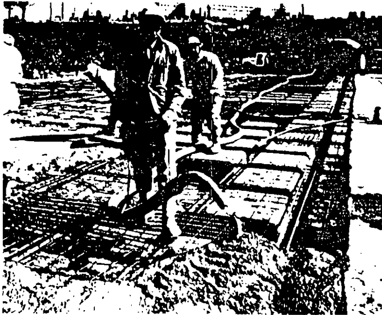
Fig. 9-3—Mediante bombeo se puede vaciar hormigón en losas sin necesidad de senderos ni de grúas. Es preciso que siempre haya comunicación directa entre el operador de la bomba y la cuadrilla de colocación.
