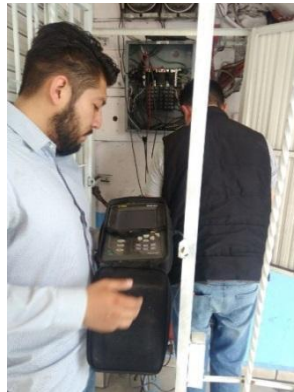
Figura 4.33. Desinstalación del analizador
