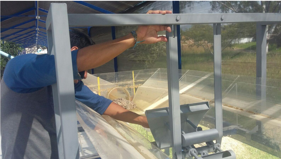
Figura 40. Colocación de compuerta en modelo físico
