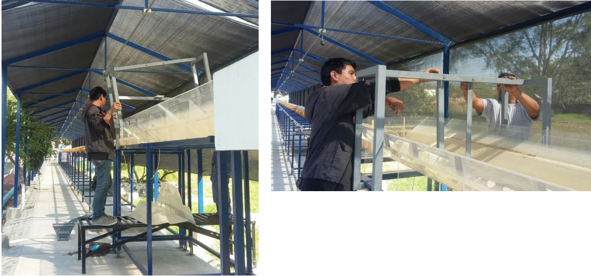
Figura 41. Colocación de soporte de acero para compuerta tipo AMIL
