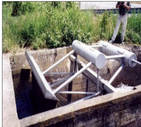
Figura 1. Compuerta autooperante tipo AMIL
