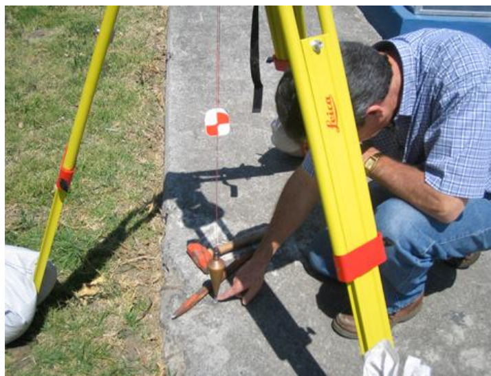
Fig. 3.1. Instalación y nivelación del equipo.
