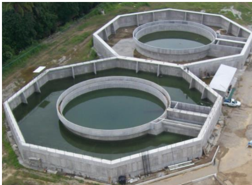
a) Tratamiento de aguas. [24]
