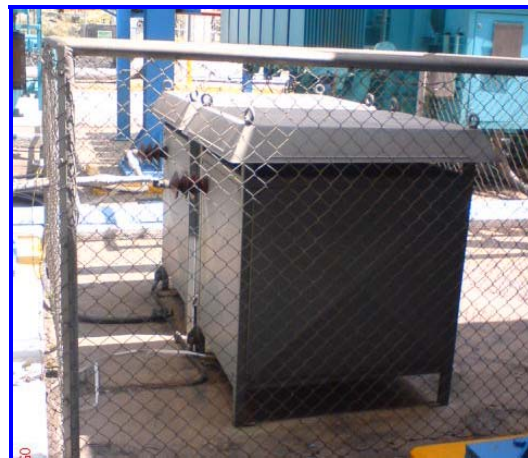
Figura 1.39 Resistencias de puesta a tierra del transformador de servicios propios de la Unidad 4.
