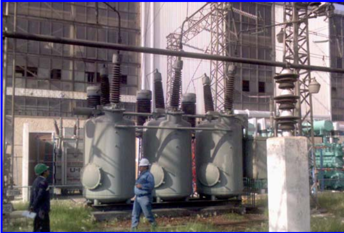
Figura 1.31 Interruptor en gran volumen de aceite.
