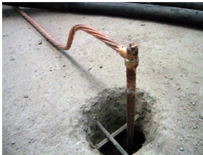
Fig. 1.11.- Varilla Copperweld conectada (soldada) a un conductor de cobre
