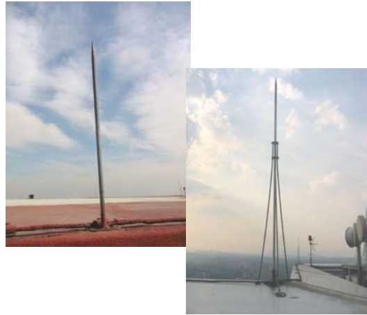
Fig. 1.12.- Electrodo de pararrayo tipo-punta de 0.3 [m] y 1.22 [m] con tripié.
