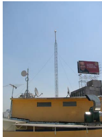
Fig. 7.17b.- Vista panorámica de la punta pararrayo tipo Ión-corona.
