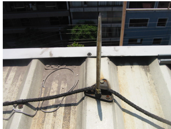
Fig. 7.20b.- Punta pararrayo 0,3 [m] ya instalada.
