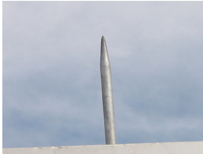
Fig. 1.5.- Punta pararrayo de 0.3 [m]
