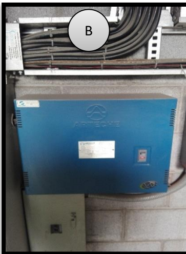
B. Banco de capacitores Arteche que se retiró por el banco de capacitores nuevo
