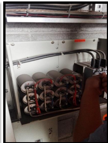
B. Banco de capacitores Arteche que se retiró por el banco de capacitores nuevo
