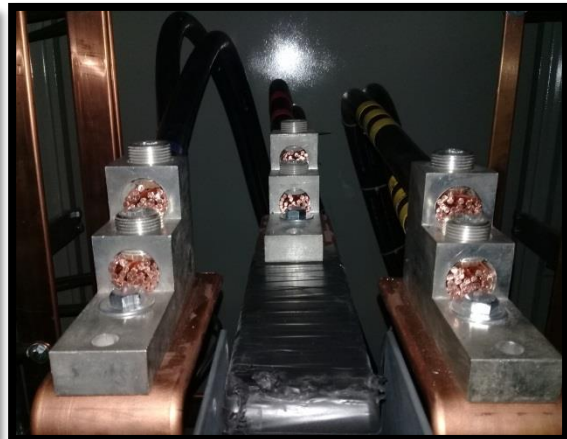
Lado secundario de TR de 750 KVA. Llegada al interruptor del equipo A-03127
