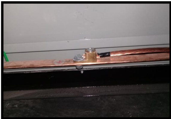
Conexión a tierra del equipo A-03127 Energización del equipo A-03127
