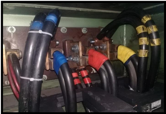
Lado secundario de TR de 750 KVA. Llegada al interruptor del equipo A-03127
