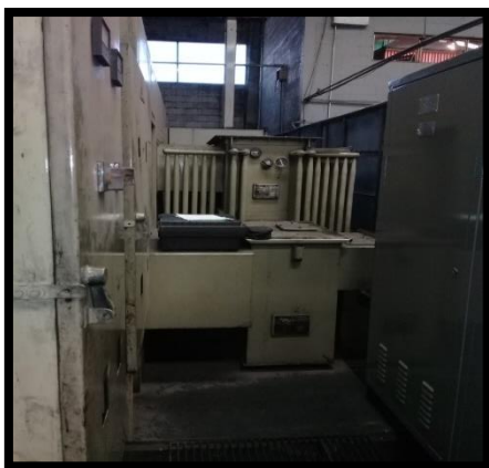
Transformador 750 kVA
