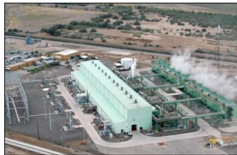
FIGURA 2.13 Central Geo termoeléctrica Cerro Prieto (Fuente: Comisión Federal de Electricidad CFE, http://www.cfe.org.mx ).
