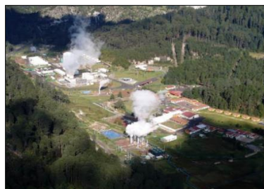
FIGURA 2.14 Central geotérmica Los Azufres (Fuente: Proyecto IMPULSA IV, Instituto de Ingeniería, UNAM).
