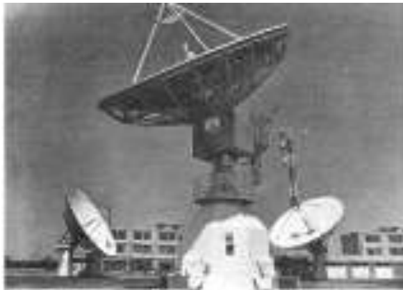
Figura 1 Antenas de la estación terrena de Tulancingo.
