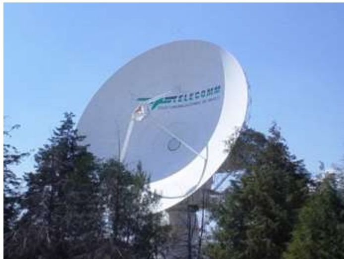
Figura 10 Ejemplo Estación Terrena Fija
