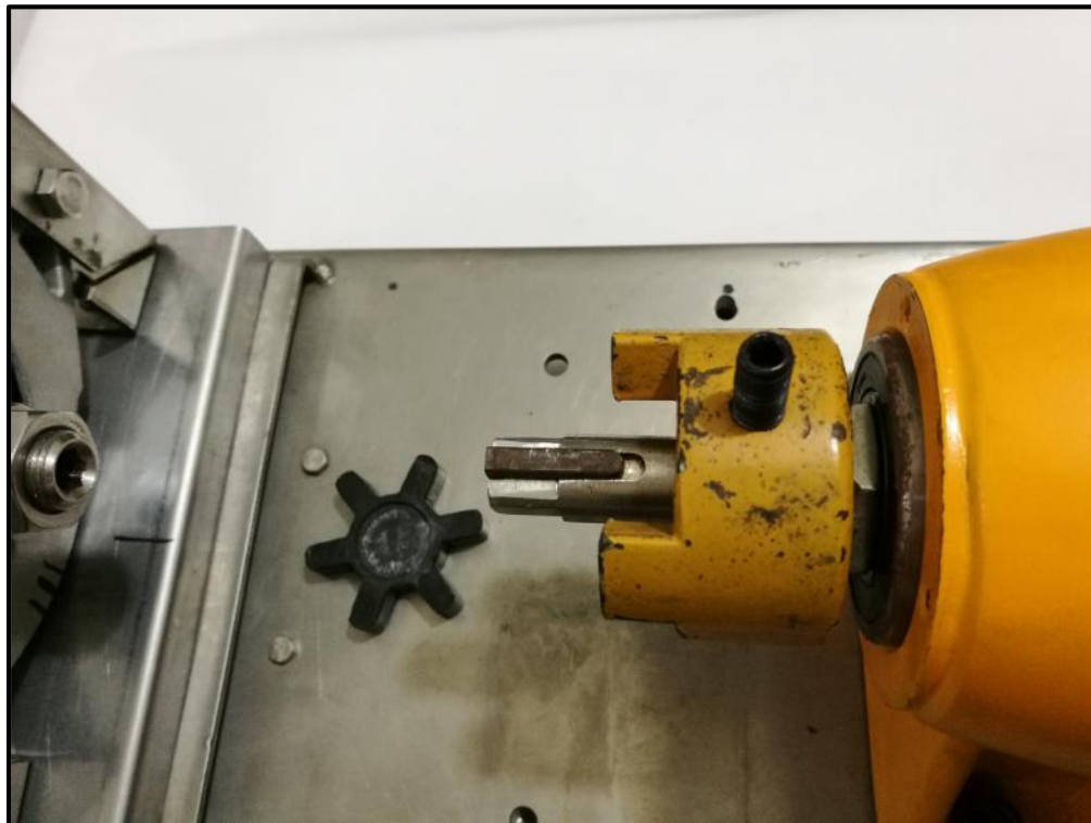
Figura 4.14 Instalación del acoplamiento en el eje de la turbina
