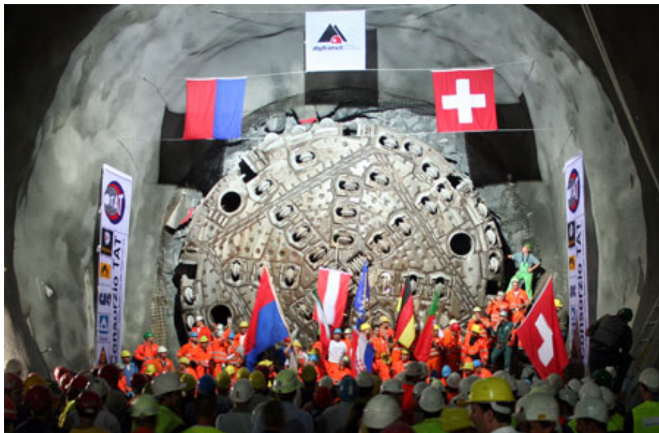
Imagen 4.- La tuneladora utilizada en la creación del túnel San Gotardo, tiene un diámetro de 9 m y una longitud de 400m. 7
