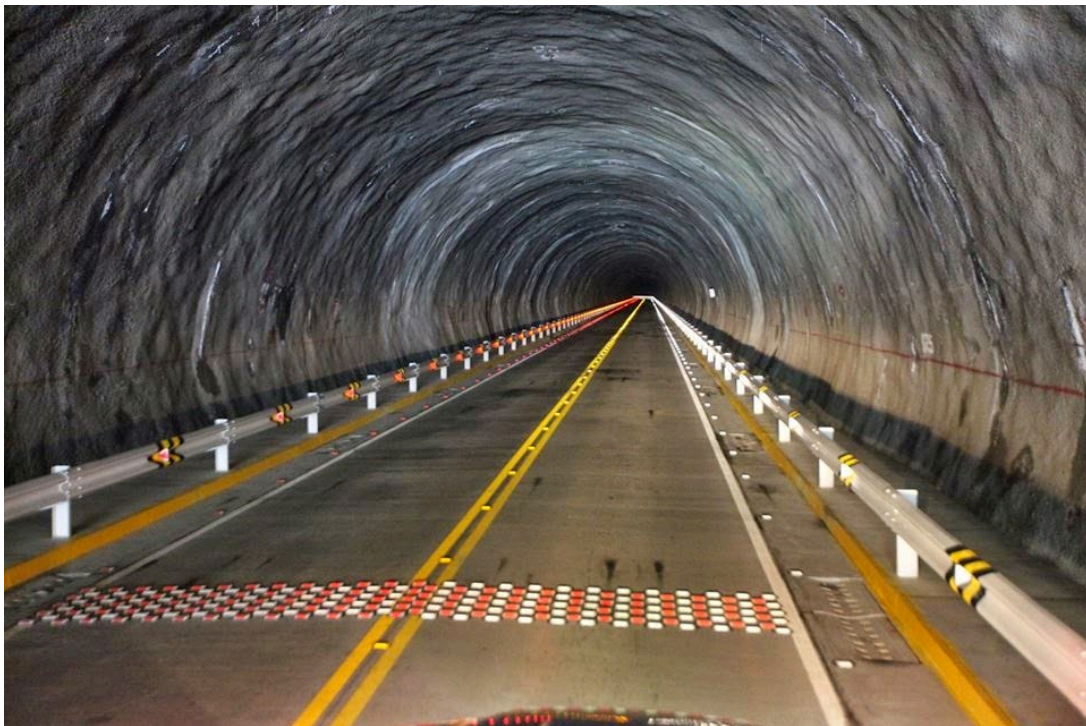
Imagen 29.- Túnel carretero peruano. 63
