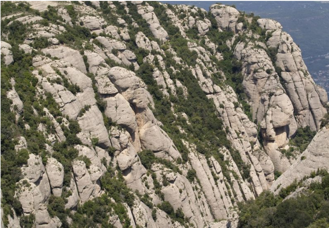
Imagen 11.- Talud con fracturas que dividen al macizo rocoso en bloques. 39
