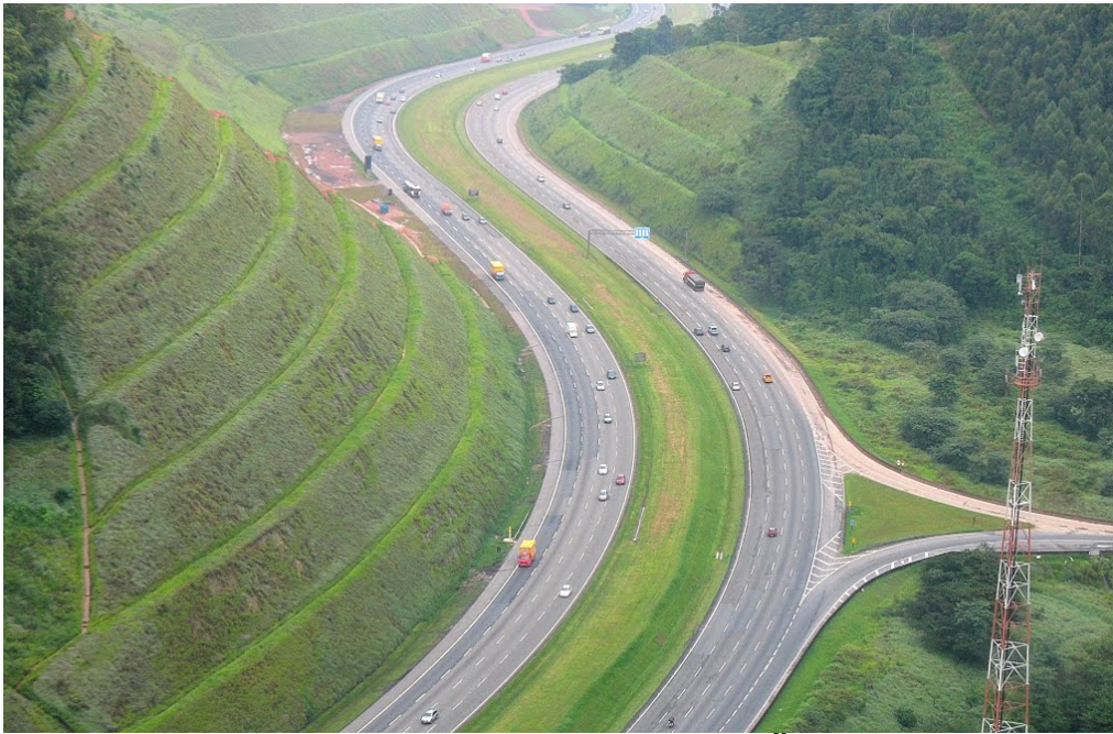
Imagen 24.- Estabilización de corte carretero. 56
