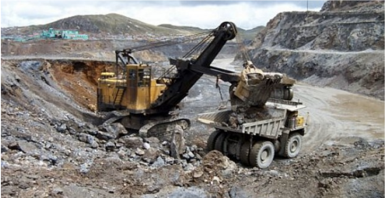
Imagen 9.- Excavación superficial de una mina a cielo abierto donde se extrae material para su explotación, las estructuras y taludes que se crean comúnmente son temporales. 12
