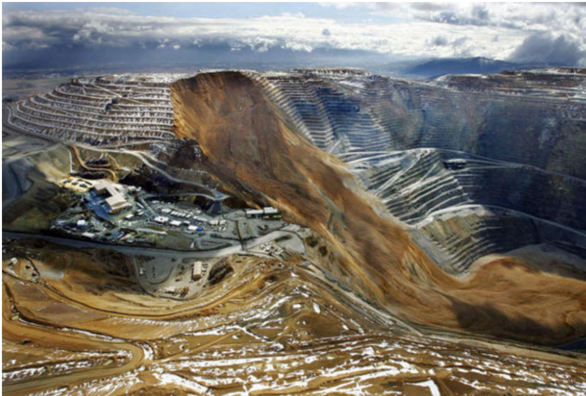
Imagen 28.-El impresionante deslizamiento de tierras de la mina de cobre de Bingham Canyon. 62
