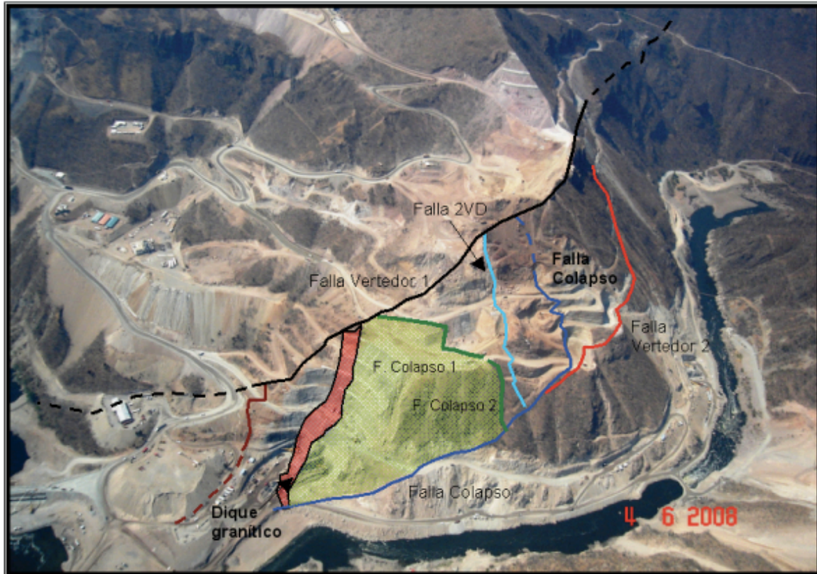
Imagen 15E.- Bloque inestable de la margen izquierda, delimitada por las fallas colapso 1, 2 y el dique granítico del portal de entrada de los túneles de desvío.
