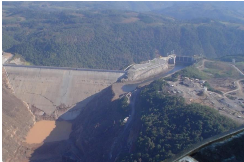
Ilustración 2.5 Presa Campos Novos, Brasil (hormigón). Colapso del túnel en 2006.
