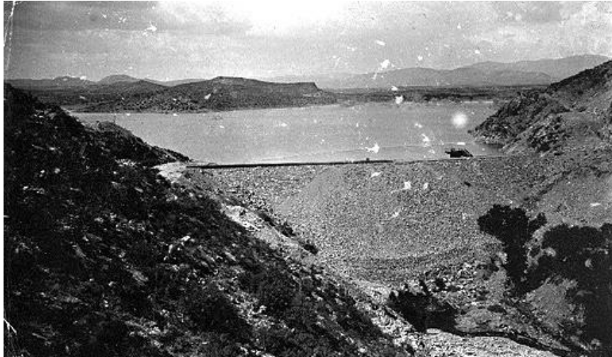
Ilustración 2.4 Presa Walnut Grove. USA,(de roca suelta). Falla por fuertes nevadas y lluvias en 1980
