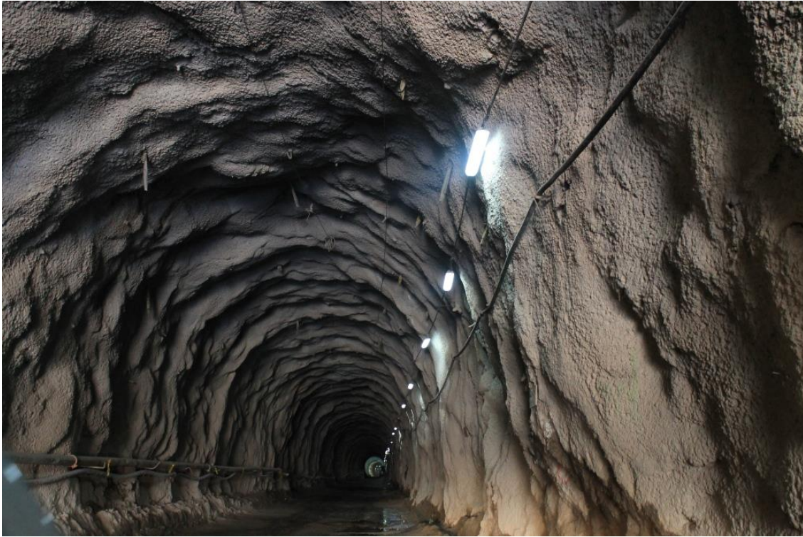
Figura 2. Concreto lanzado como sistema de sostenimiento en obras subterráneas. Foto tomada de http://blog.360gradosenconcreto.com/proyecto-hidroelectrico-sogamoso-hidrosogamoso-megaobra-en-concreto/
