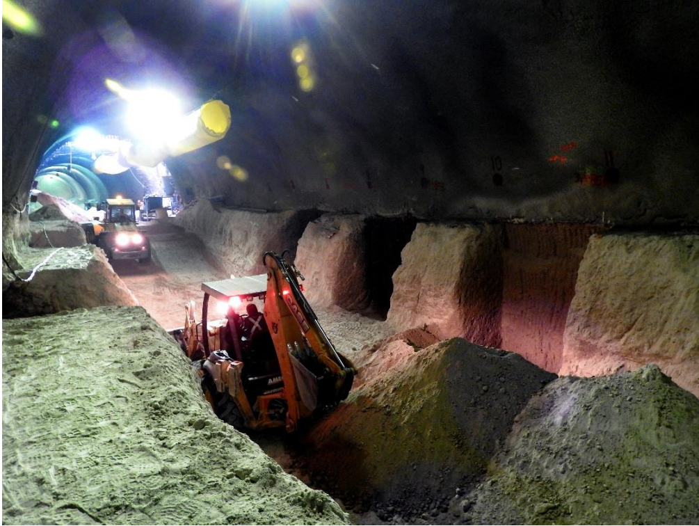
Figura 156. Banqueos laterales por bataches.
