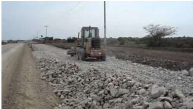
Figura 2.3. Pedraplén de poca altura sobre la carretera Federal Chiapa de Corzo
