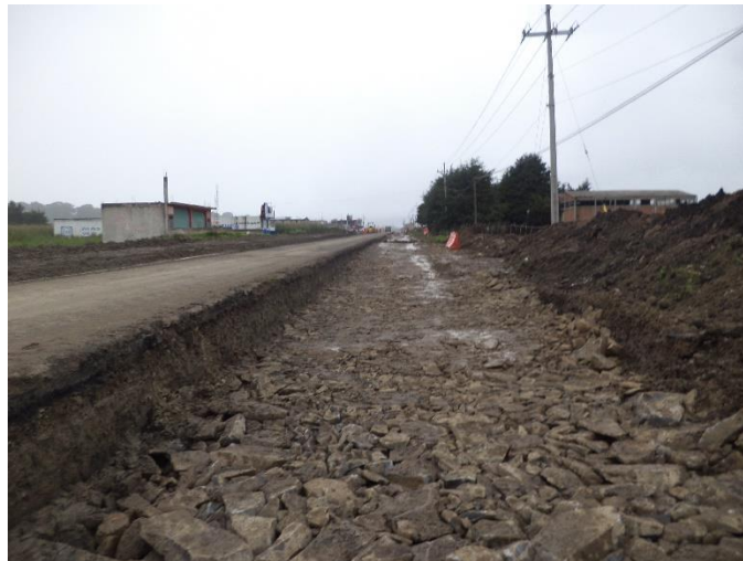
Figura 5.4 Extendido y acondicionamiento de humedad en carretera Villa Victoria – San José del Rincón
