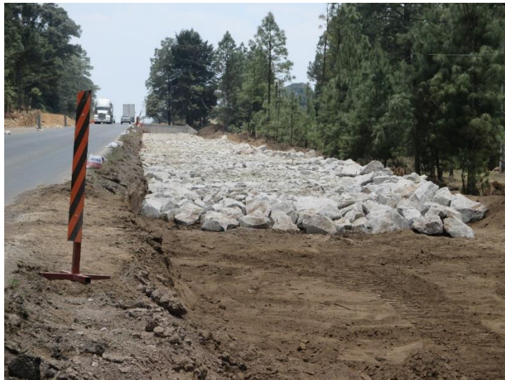
Figura 5.2 Extendido de pedraplén en Carretera Villa Victoria – San José del Rincón
