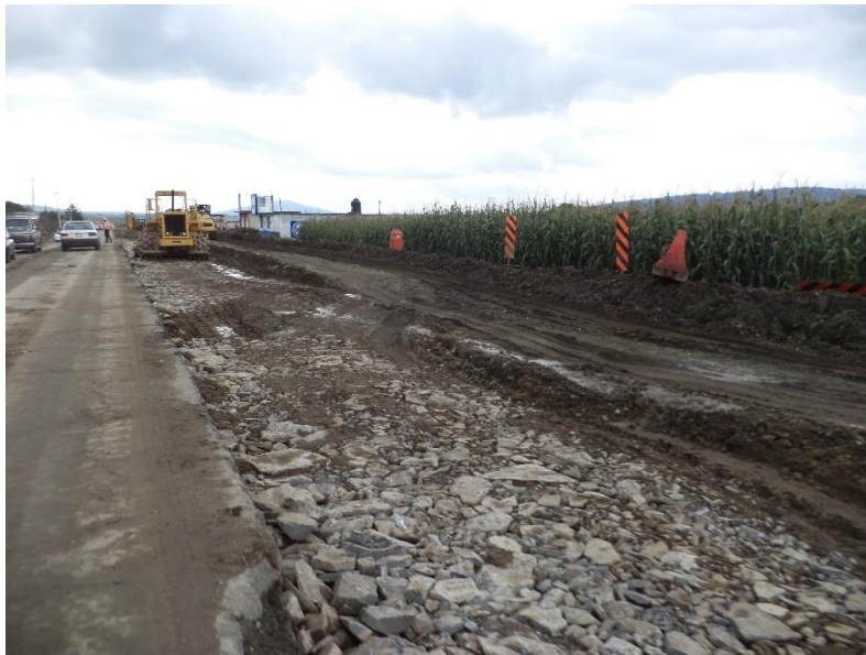
Figura 5.5 Compactación con pata cabra
