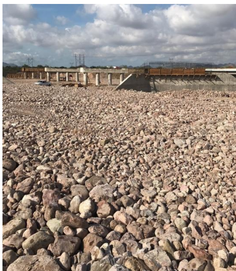
Figura 5.6 Compactación de Pedraplén con rodillo
