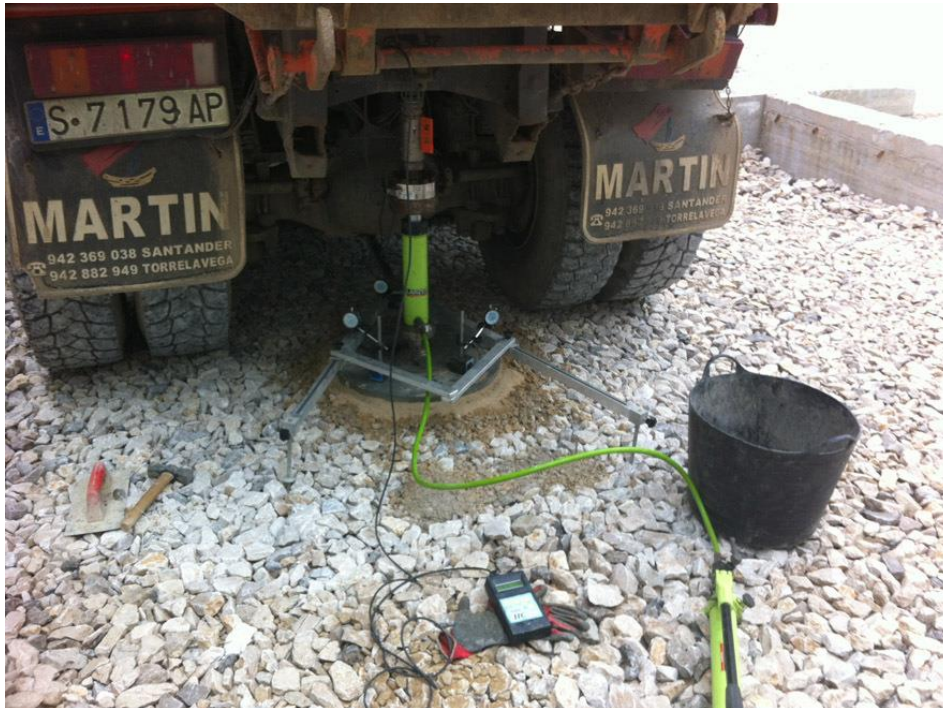
Figura 5.8 Ensayo placa de carga.
