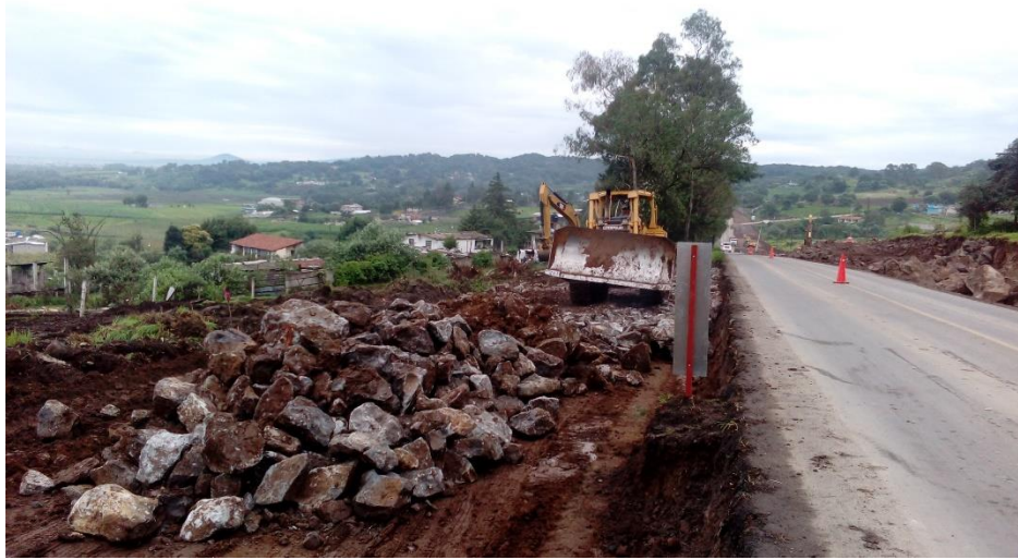
Figura 5.3 Extendido de material mediante bulldozer carretera Villa Victoria – San José del Rincón
