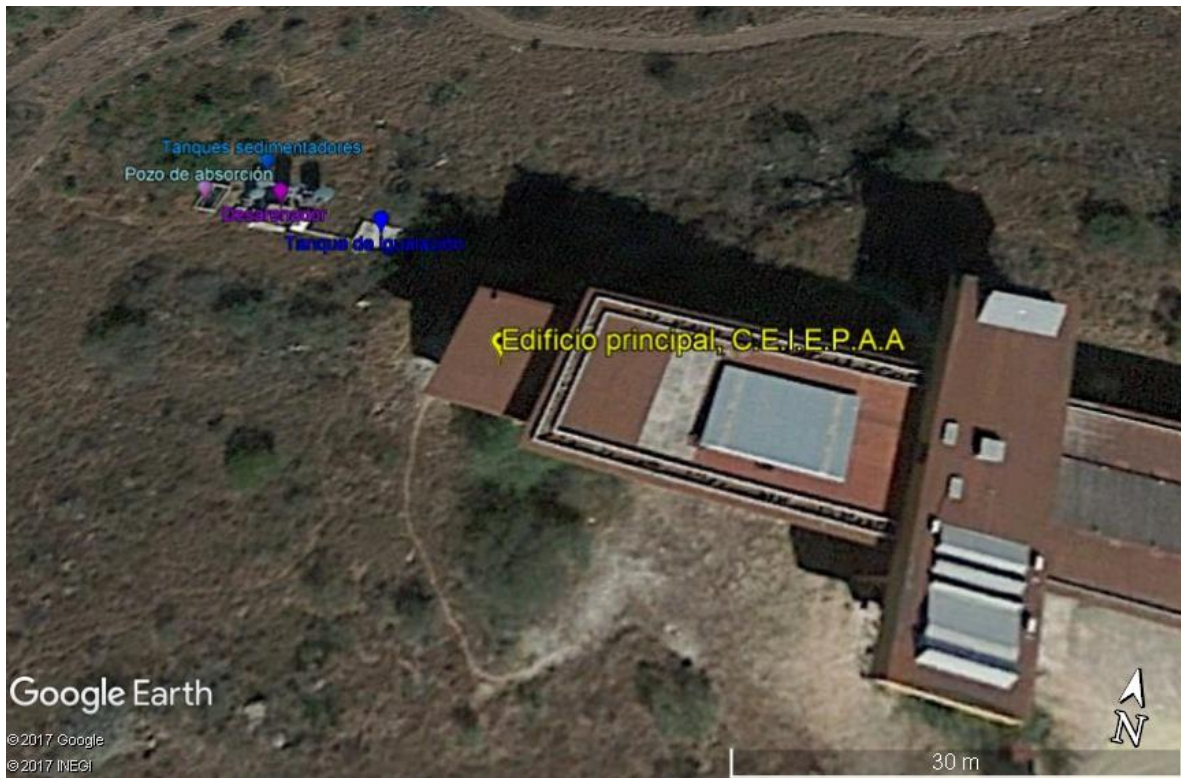
Figura 3.1. Instalaciones de PTAR en Edificio Principal.
