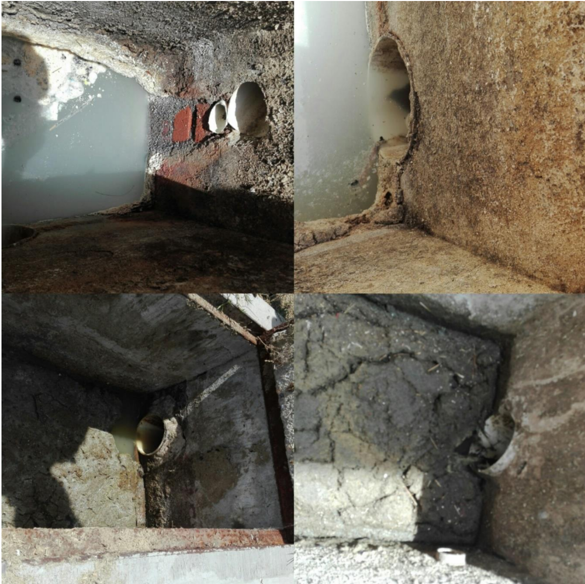
Figura 3.14. Registros de la red de alcantarillado de bovinos
