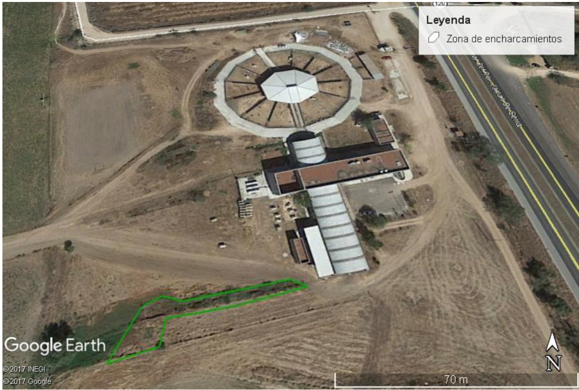
Figura 3.9. Zona de encharcamientos
