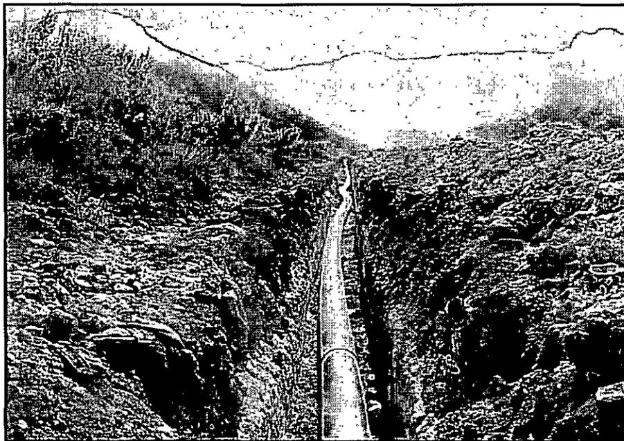
FIGURA 14 TUBERÍA COLOCADA EN LA ZANJA.
