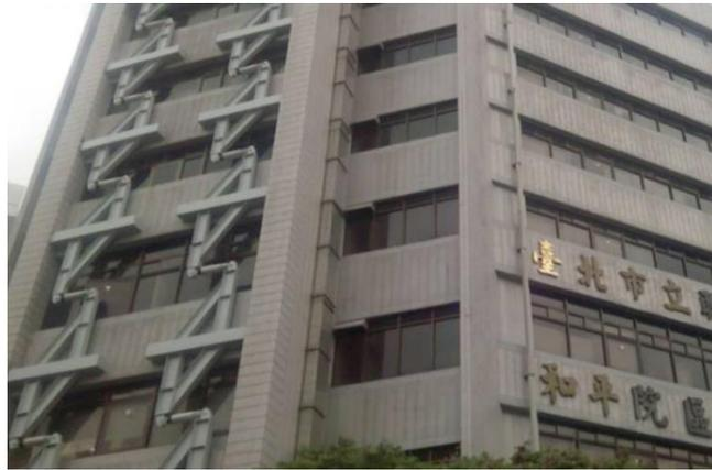
**Fig. 1.3 Amortiguadores viscosos instalados en el Taipei City Hospital (Mageba México)**
