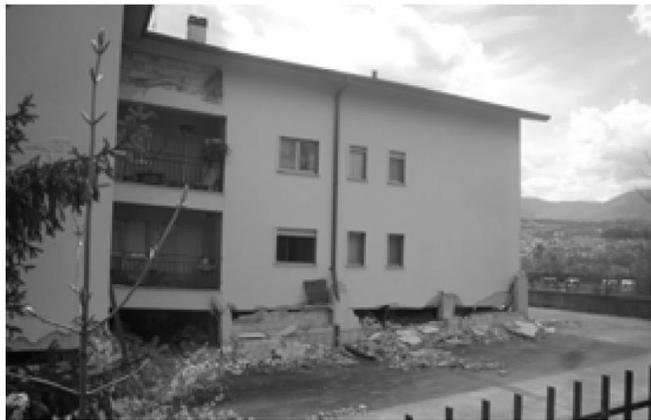
**Fig. 1.2 Colapso de edificio por piso suave en el sismo de L'Aquila (Italia 2009)**
