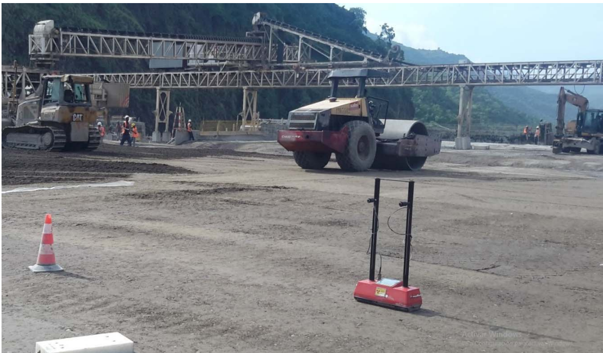
Figura 4- 39 Medición de densidad con densímetro nuclear de doble barra
