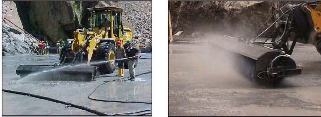
Figura 4- 17 Tratamientos para junta tipo II
