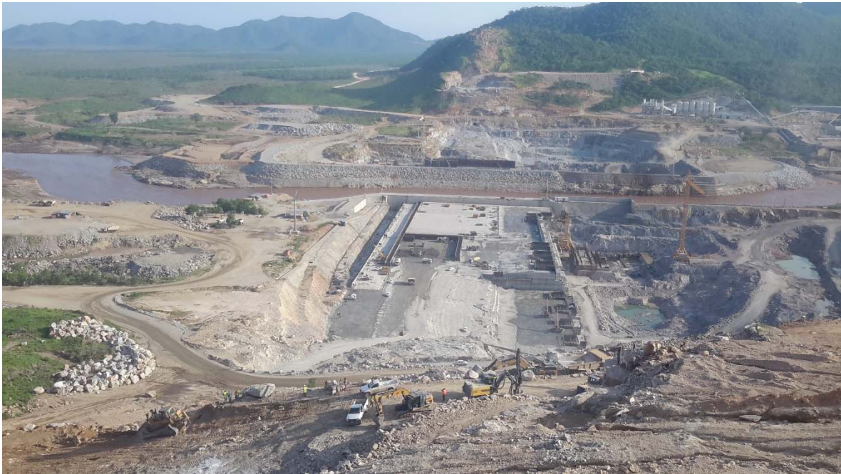
Figura 4- 43 Vista desde margen izquierda hacia margen derecha
