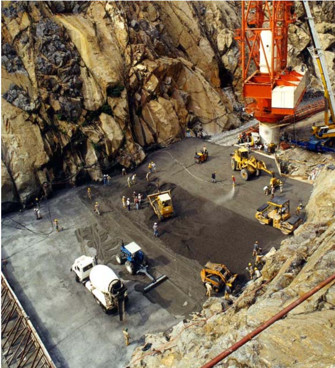
Figura 4- 12 Extendido y colocación de las primeras capas de CCR
