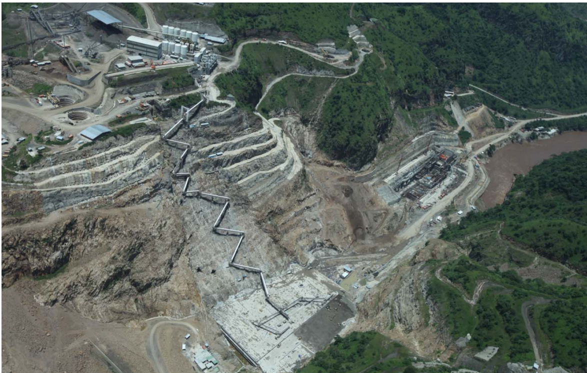
Figura 4- 31 Primeras capas de CCR
