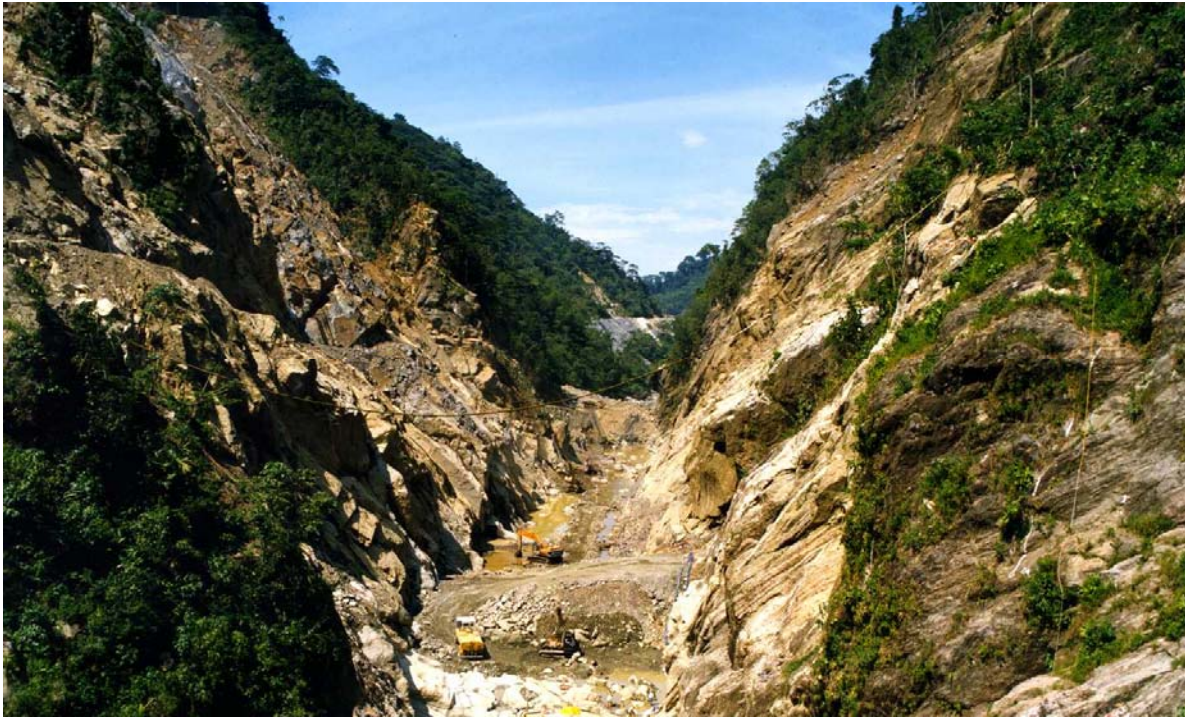
Figura 4- 10 Limpieza en cauce y estribos
