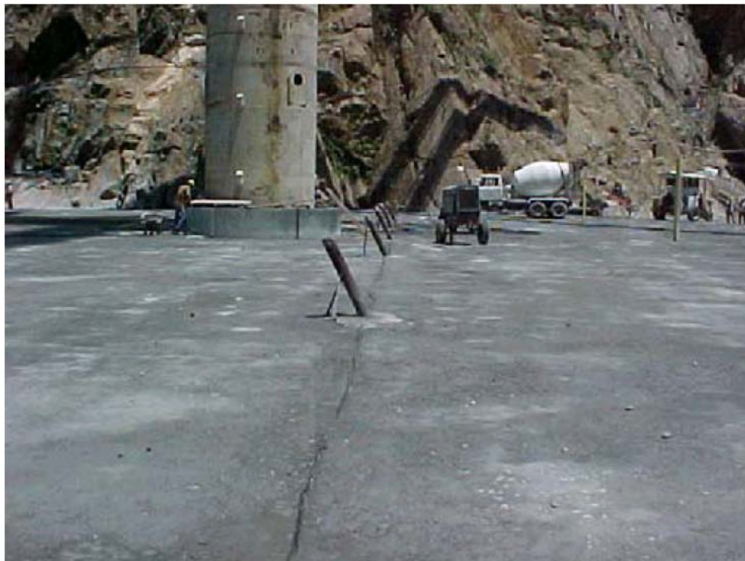
Figura 4- 16 Junta longitudinal
