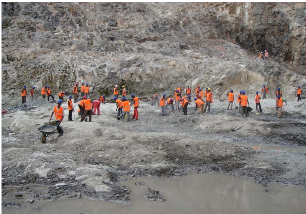
Figura 4- 30 Trabajos de limpieza en el cauce de la presa
