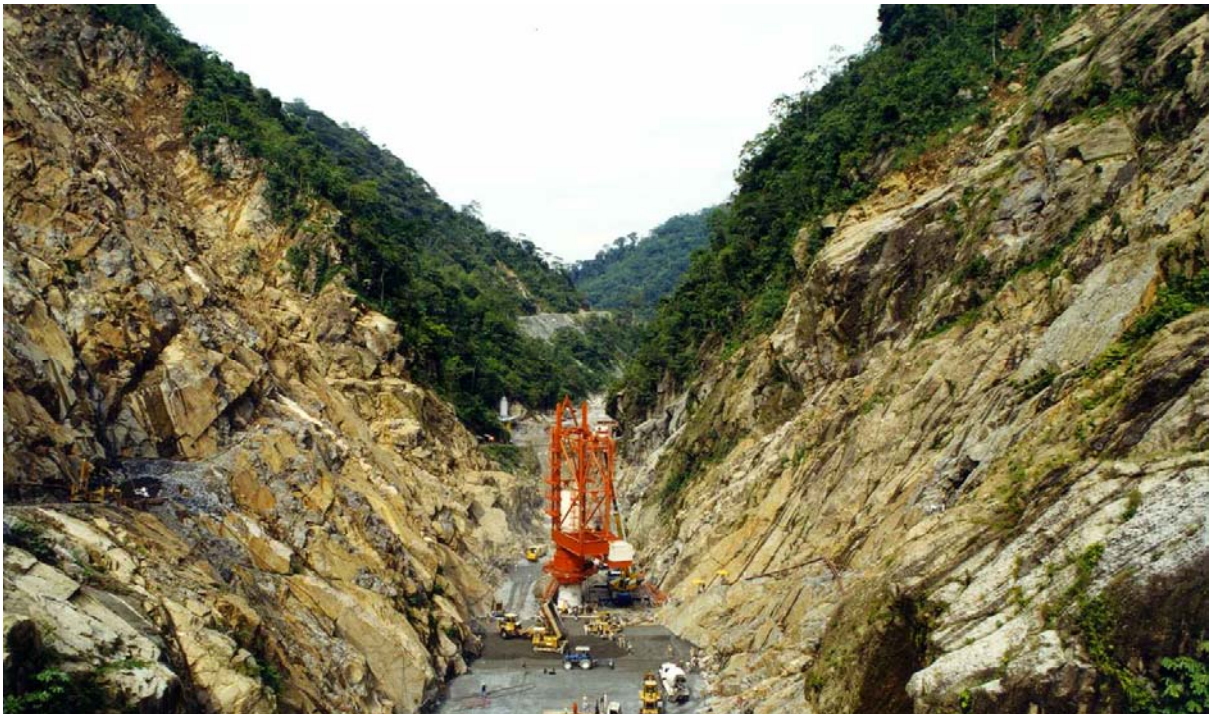
Figura 4- 11 Inicio de las primeras capas de CCR
