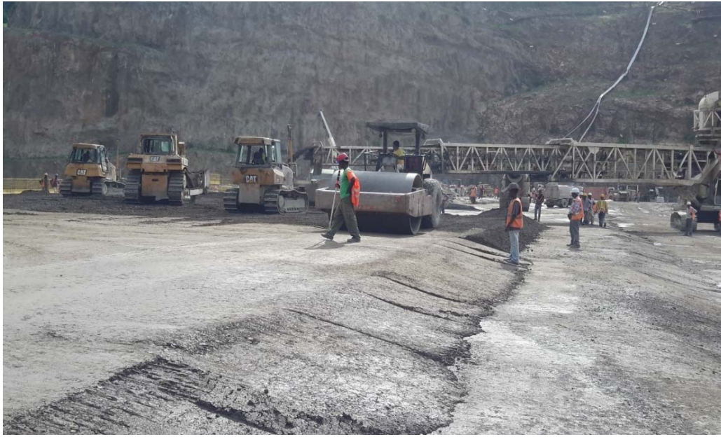
Figura 4- 35 Extendido y compactación de CCR
