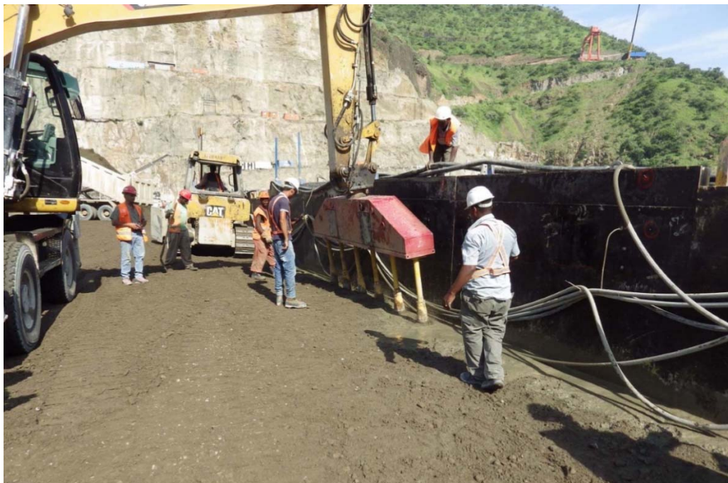
Figura 4- 36 Vibrado de concreto enriquecido en el paramento aguas arriba
