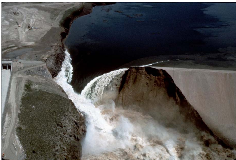
Figura 1- 15 Falla de Teton Dam (Web)
