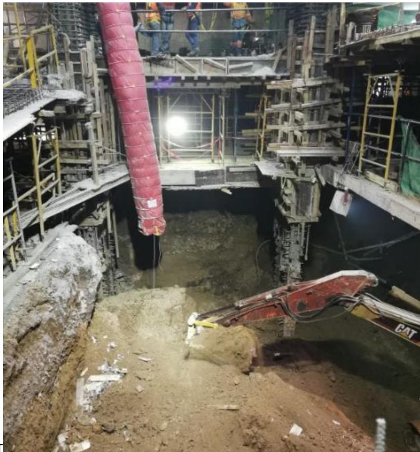
*Figura 4 Ejecución de proyecto Insurgentes 700 con método de Top-Down (CIMESA, 2017)*
