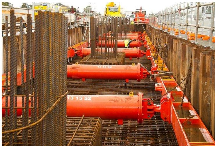
*Figura 1 Uso de precarga en excavaciones. (Honvajec, Joseph. 2015)*
