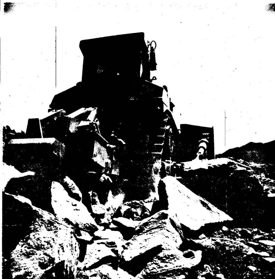
TRABAJANDO EN UN BANCO DE ROCA.
