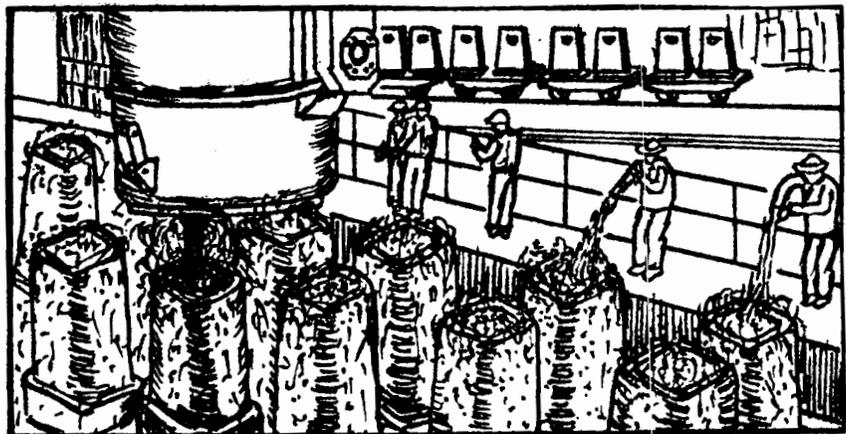
FIG.13. COLADO DEL ACERO EN LAS LINGOTERAS.
