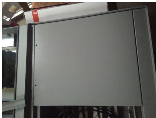
Fig. 7.8 Panel ciego para interruptor con dos puntos de fijación a la envolvente.
