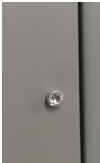
Fig. 7.7 Tornillo de fijación tamaño M6 es posible de retirar con una herramienta convencional.
