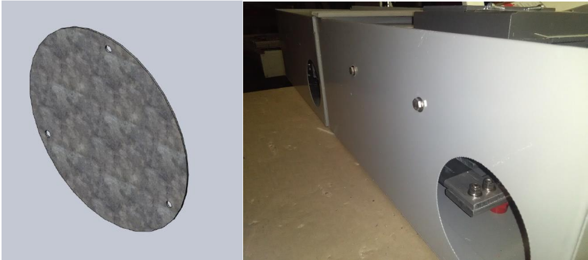
Fig. 7.10 Orificio de acometida para alojar un tubo Conduit de 4 pulgadas, junto con disco removible con un destornillador.
