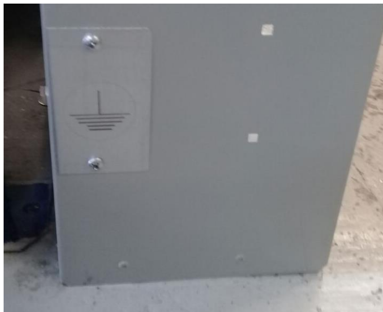
Fig. 7.21 Puntos de fijación con remaches situadas a no más de 38.1 mm de las pestanas.
