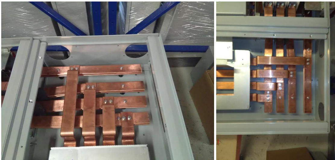
Fig. 7.11 La parte superior e inferior de la envolvente fueron provistas con placas de metal desprendibles para alojar una tubería de 4 pulgadas, como lo dicta la norma un orificio circular de 117.88 mm de diámetro.
