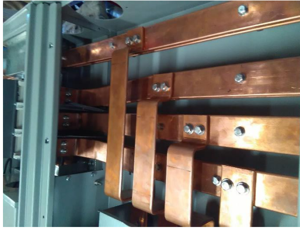
Fig. 7.5 Arreglo de barras de cobre elegidas posteriormente a su cálculo.
