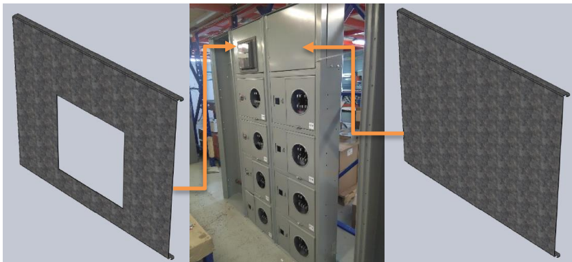
Fig. 7.28 Panel para bus de barras.
