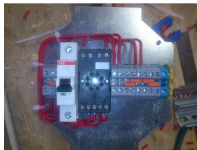
Fig. 3.3 Conexión de la bobina de un arrancador utilizando equipo ABB®
