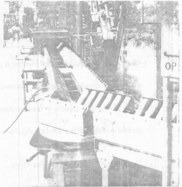
Adecuada línea de transportadores de rodillos en "V" para la sección de machuelado de piezas de motor V8 de gasolina en la línea de producción en Fábricas Automex, S. A. de Toluca, Edo. de México.
