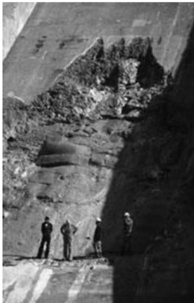
Figura 23. Daños por cavitación, Presa Karun, Irán
