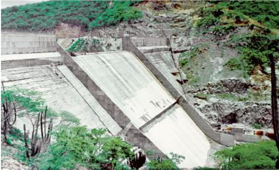
Figura 27. Aireador de la presa Trigomil, México.
