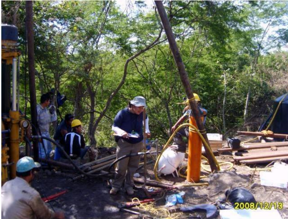
A-4 – Realización de pruebas de permeabilidad
