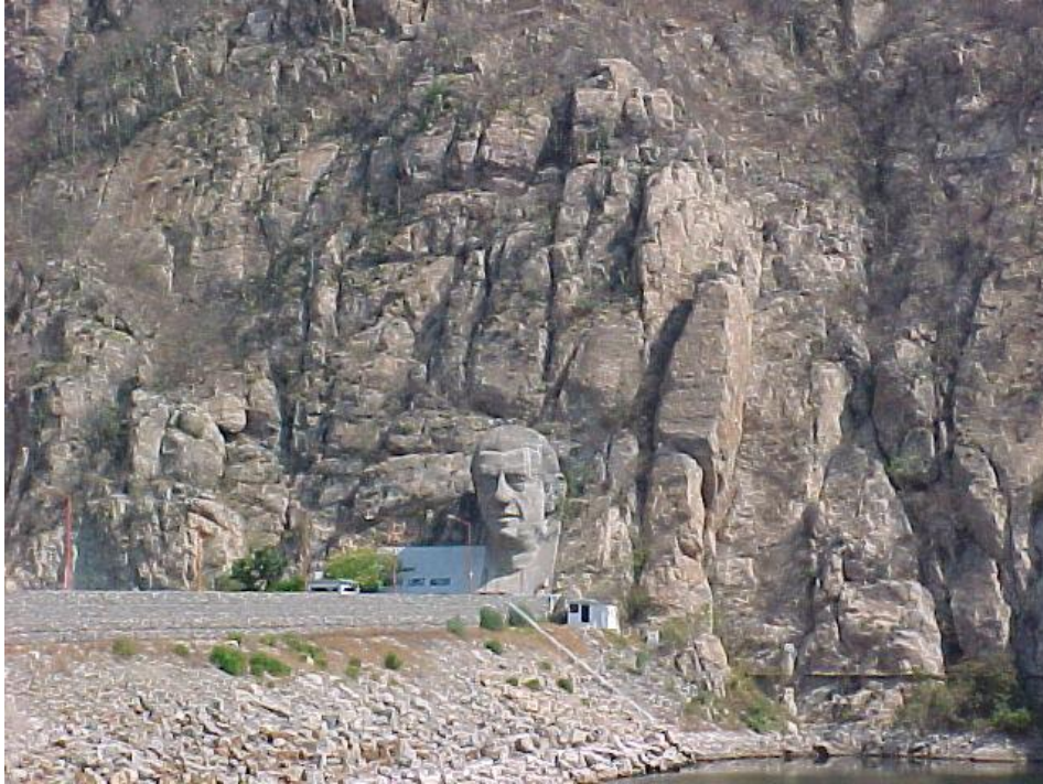
Fotografía II.1 - Depósitos volcanosedimentarios masivos y muy fracturados. Afloran extensamente, en forma discontinua, desde la zona de la C. H. El Infiernillo, hasta la costa del Océano Pacífico.
