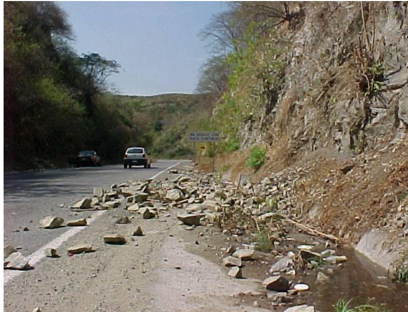
Fotografía II.12 - Bloques caídos del afloramiento de dioritas de hornblenda muy fracturadas, en la carretera Petacalco, Gro. - Lázaro Cárdenas, Mich. a un costado del poblado La Villita; margen derecha del río Balsas, cerca de la Zona del Vertedor.
