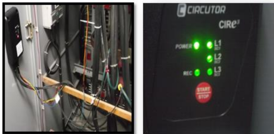
Figura 20. Conexión del analizador de redes eléctricas
