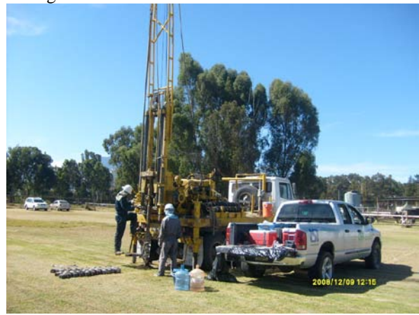
Fotografía 34. Muestreo de suelo en el sondeo SDS-3.
