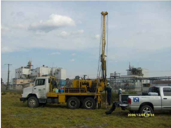
Fotografía 31. Muestreo de suelo en el sondeo SNE-6.
