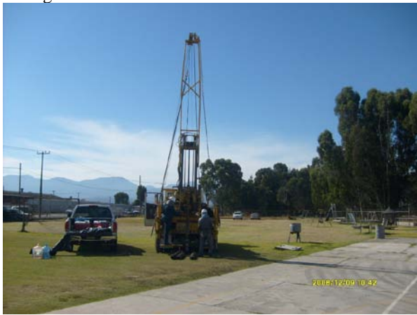
Fotografía 33. Muestreo de suelo en el sondeo SDS-2.
