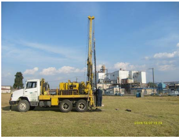
Fotografía 27. Muestreo de suelo en el sondeo SDN-7
