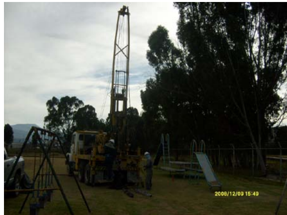
Fotografía 36. Muestreo de suelo en el sondeo SCF-11.
