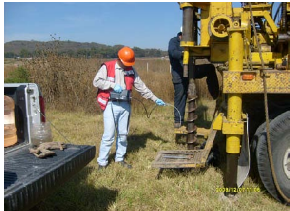
Fotografía 26. Detección de vapores orgánicos y explosividad
