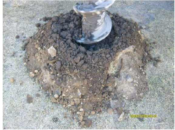
Fotografía 32. Muestreo de suelo en el sondeo SDS-1
