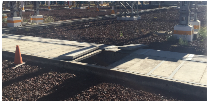
Fig. 2.13 Trincheras superficial
