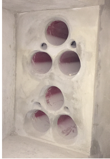
Fig. 2.19 Ductos en configuración delta
