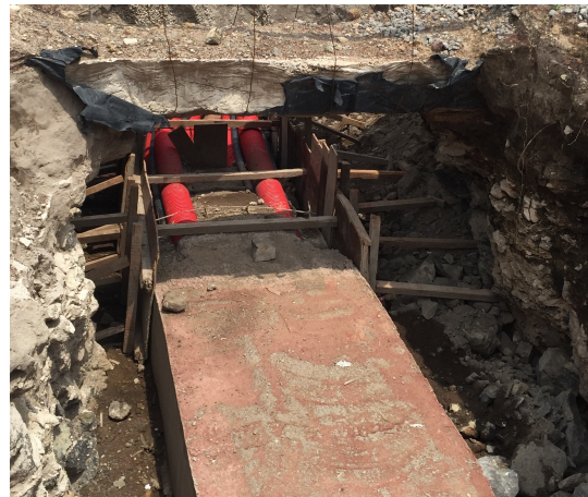
Fig. 2.4 Banco de ductos en concreto
