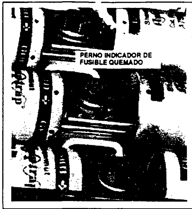
FIG. 21. FUSIBLES BUENOS Y QUEMADOS EN EL PANEL FM464. E-29415A-S
