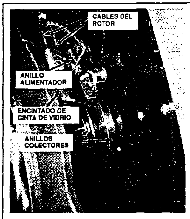
FIG. 4. ANILLOS COLECTORES DEL ALTERNADOR Y CONJUNTO DE PORTAESCOBILLAS. E-14143-S
