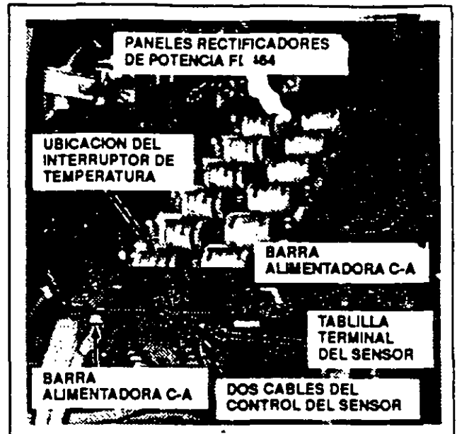
FIG. 19. JUEGO DE TRES PANELES FM464 (UNO CON LA CUBIERTA REMOVIDA). E-29413A-S
