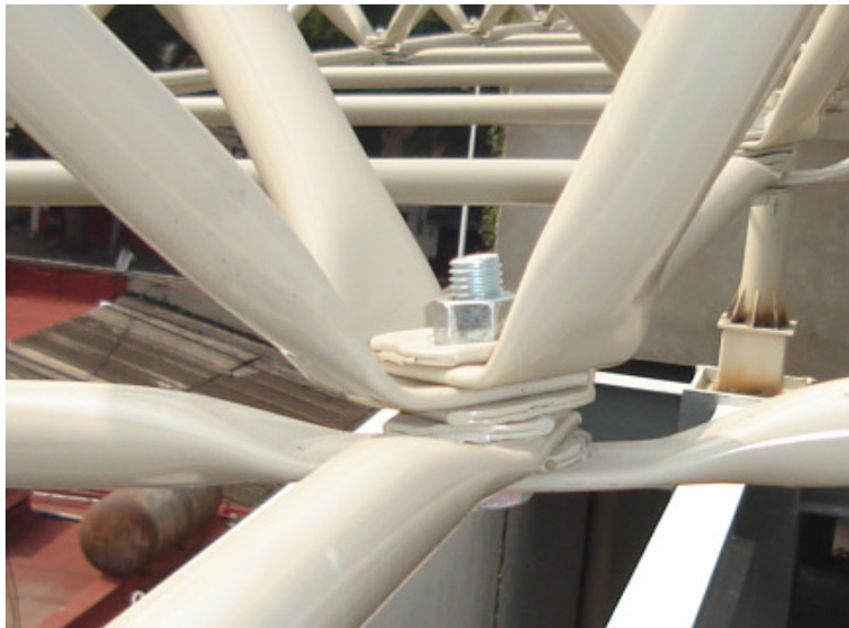
Fig. 4. 23 Orden de inserción de las mallas del nodo inferior
