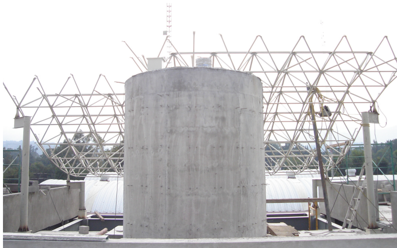
Fig. 4. 33 Vista lateral de la primera mitad de la estructura
