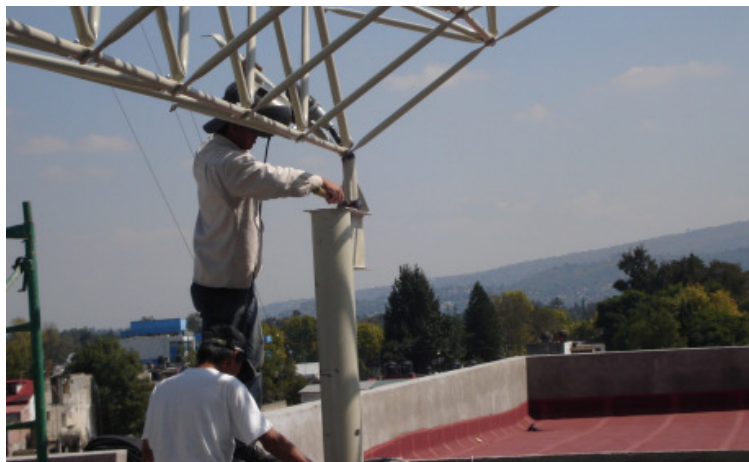
Fig. 4. 37 Ajuste de la columna del lado izquierdo
