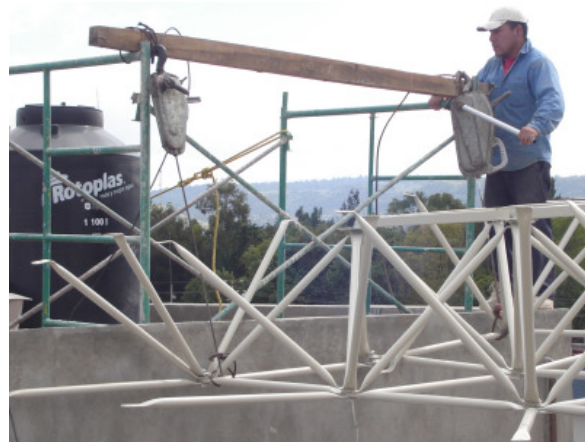
Fig. 4. 26 Levantamiento del subensamblado inicial
