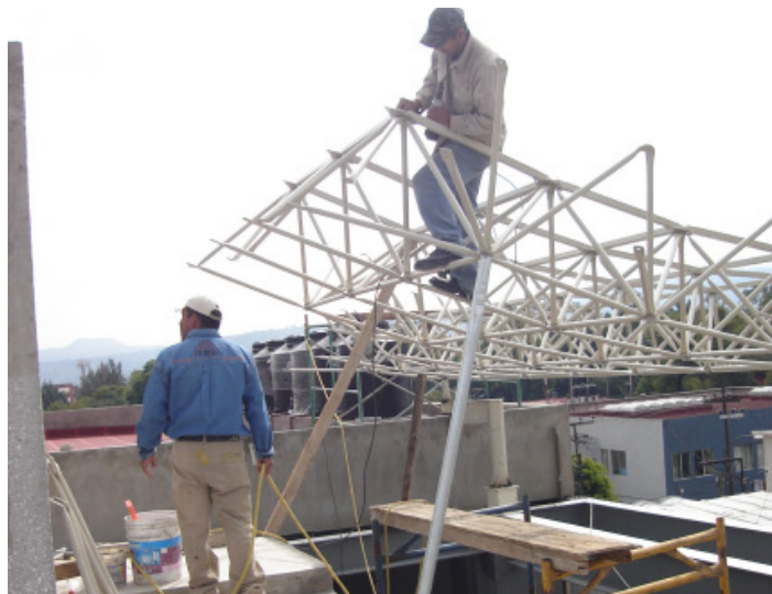
Fig. 4. 29 Ensamble de las hileras centrales
