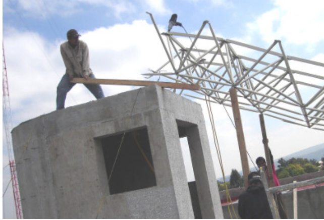
Fig. 4. 30 Levantamiento de las hileras centrales
