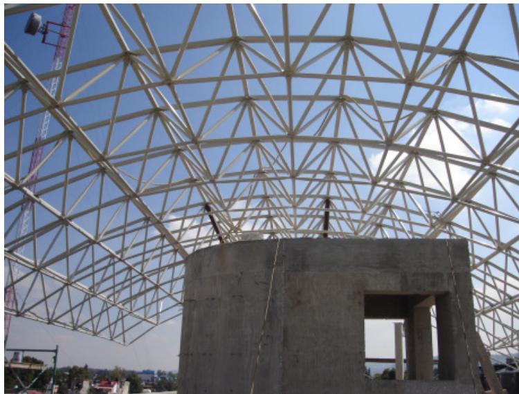
Fig. 4.34 Ensamble de las mallas de la segunda mitad de la estructura
