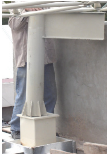
Fig. 4. 27 Colocación de la columna sobre la base
