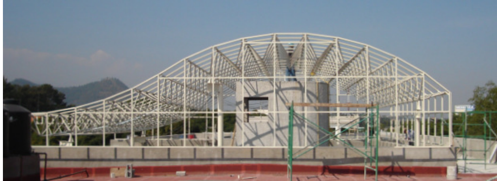
Fig. 4. 43 Vista frontal final de la estructura
