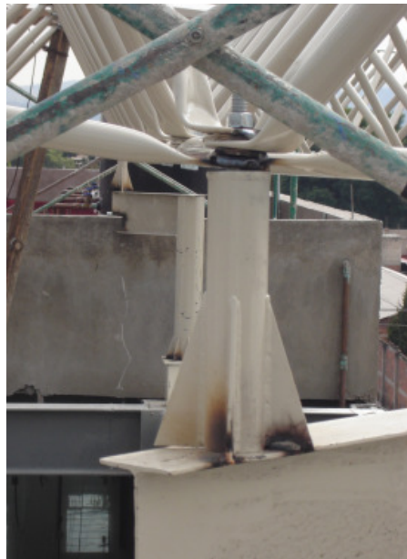
Fig. 4. 28 Colocación y soldadura del nodo de soporte
