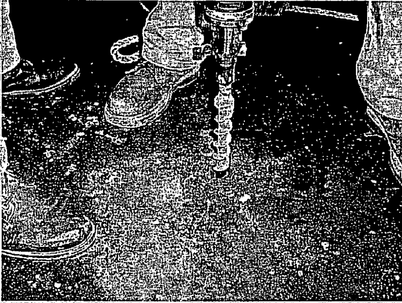
Perforaciones para gasometría ("discretas" por su diámetro pequeño)
