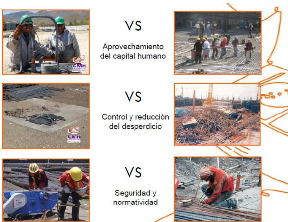
Figura 2. Aquí se muestra el sistema utilizado por CMH con equipo especializado de doblado, corte y personal capacitado, contra métodos tradicionales utilizados comúnmente en obra donde se realizan estas mismas actividades
