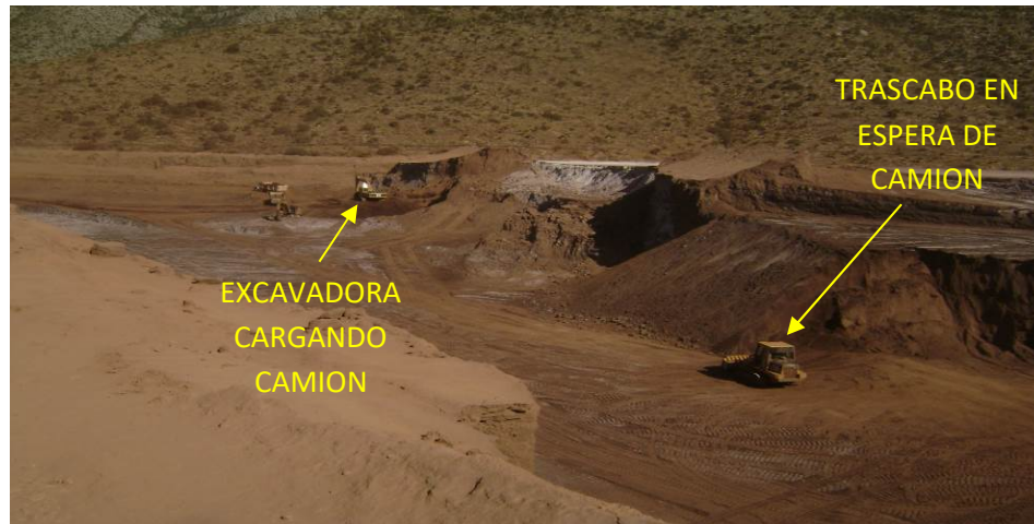
Figura 32 Otra vista donde se muestra el cargado de camiones con dos diferentes equipos
