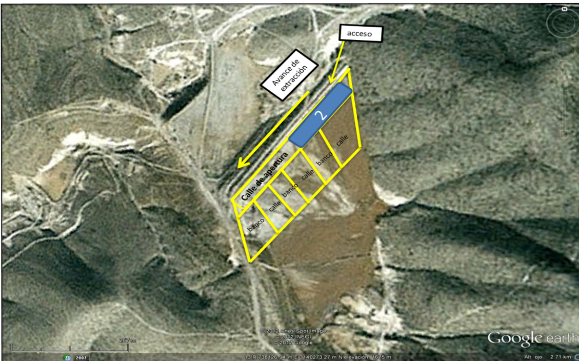
Figura 25 Paso número 2 continuidad y avance de la calle hacia la falda o límite de presa
