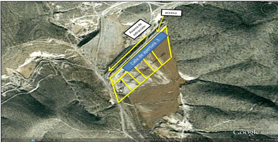
Figura 26 paso 3 de avance en calle
