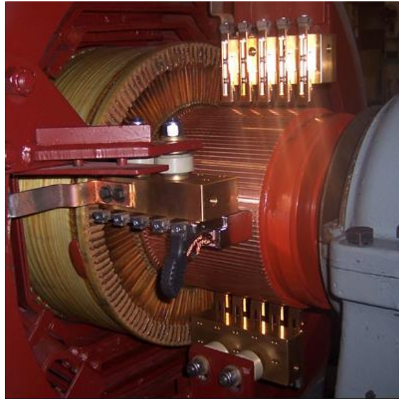
Figura 2.3.8 Excitación rozante del generador. [11]
