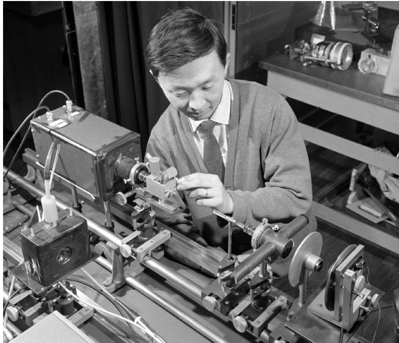
Figura 5. Charles Kao en 1965, realizando pruebas a la fibra óptica en STL
