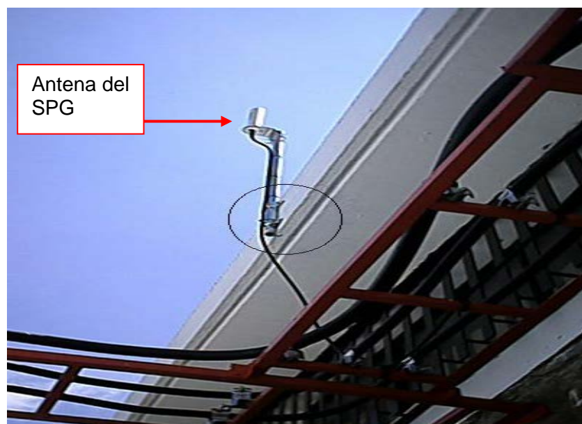
Figura 4.20. Instalación de la antena del SPG.
