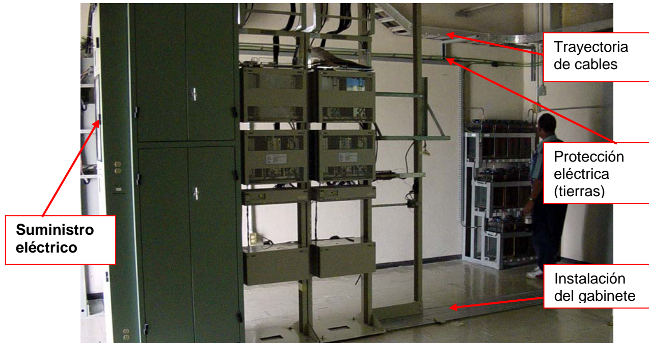
Figura 4.5. Sala donde se instalará el SMG.
