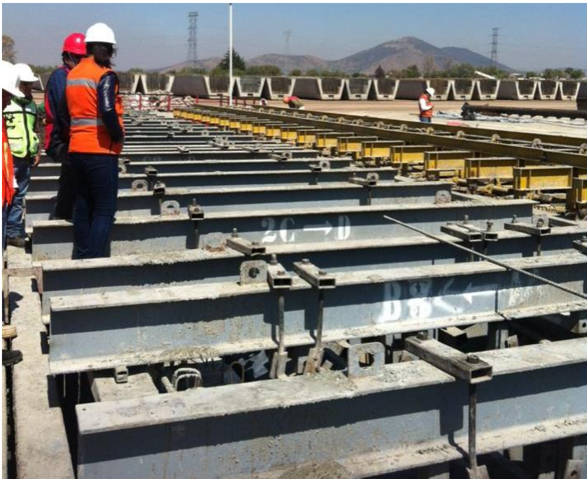
Figura 33. Moldes metálicas para trabe cajón en planta PRET La Arboleda.
