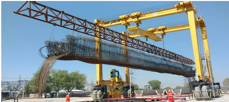
Figura 16. Marco MI-JACK empleado en planta PRET “La Arboleda”.
