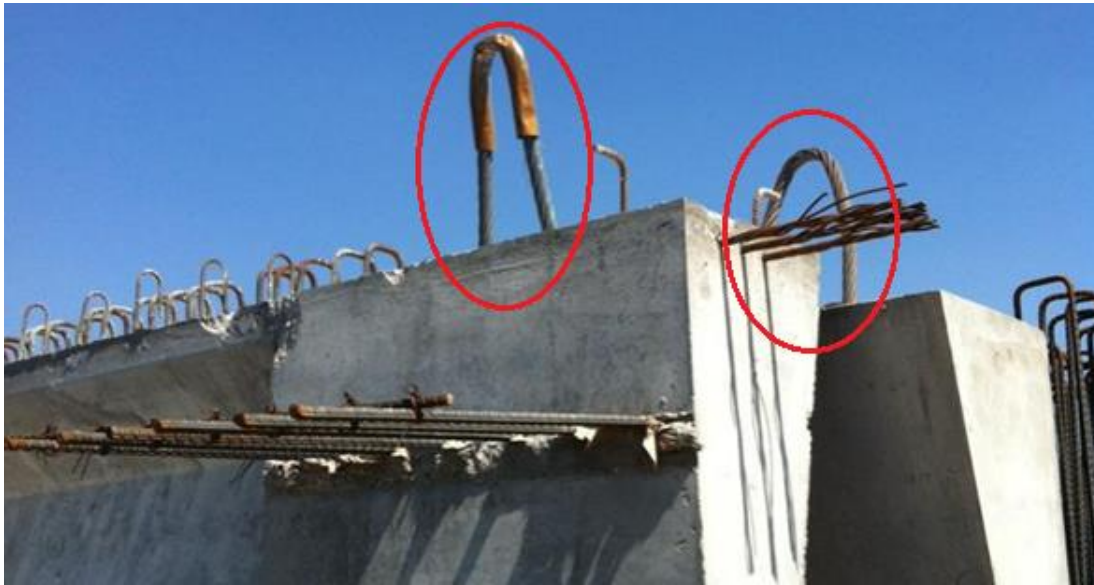
Figura 41. Dispositivos de Izaje de trabes cajón.
