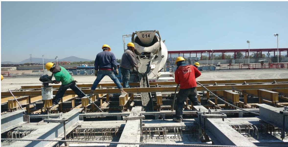
Figura 45. Colocación y compactación del concreto.
