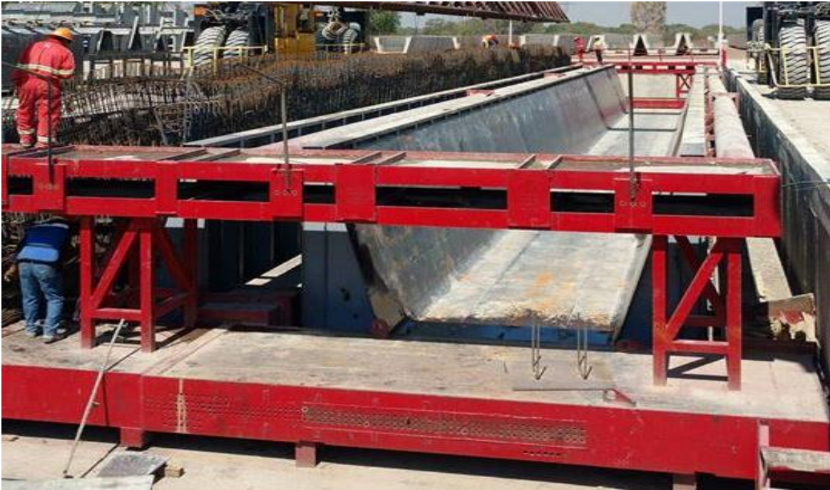
Figura 34. Trazo y nivelación topográfica.
