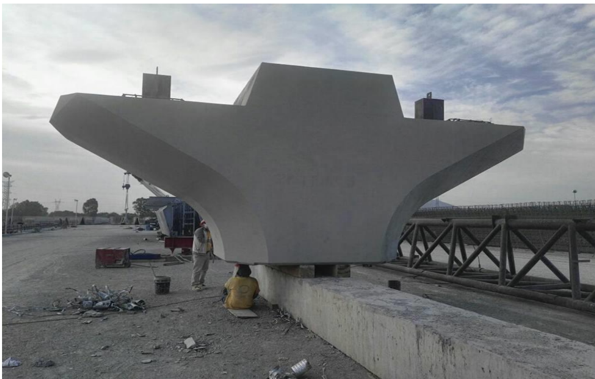
Figura 51. Ejemplo del proceso de detallado en un capitel encomendado a PRET.
