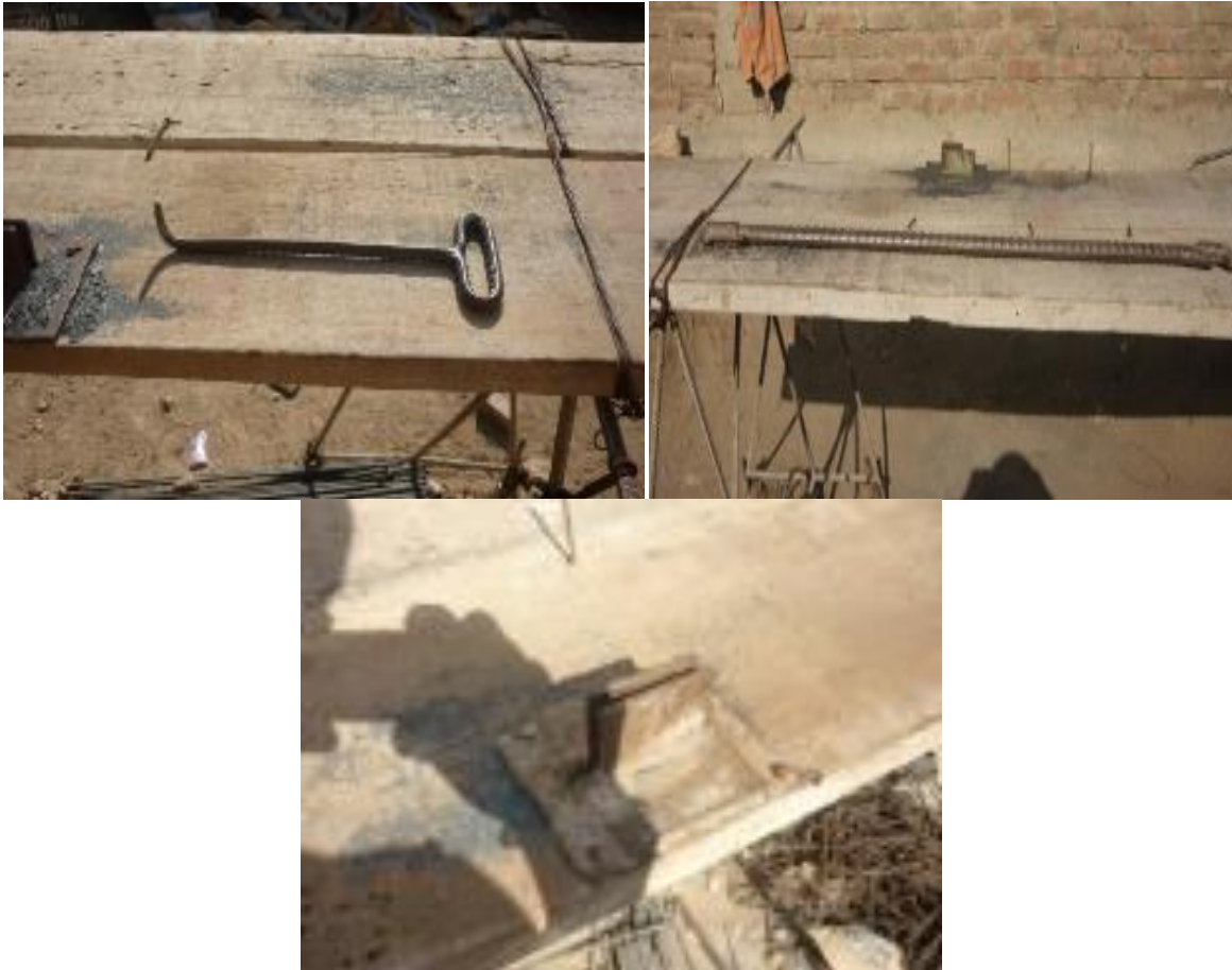
Figura 35. Herramientas de habilitado y armado de acero de refuerzo.
