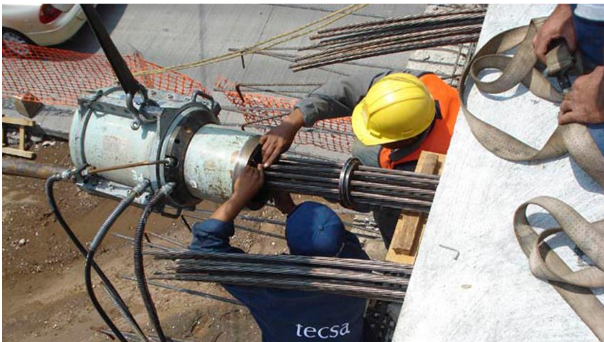
Figura 42. Enhebrado típico de torones a gato hidráulico.
