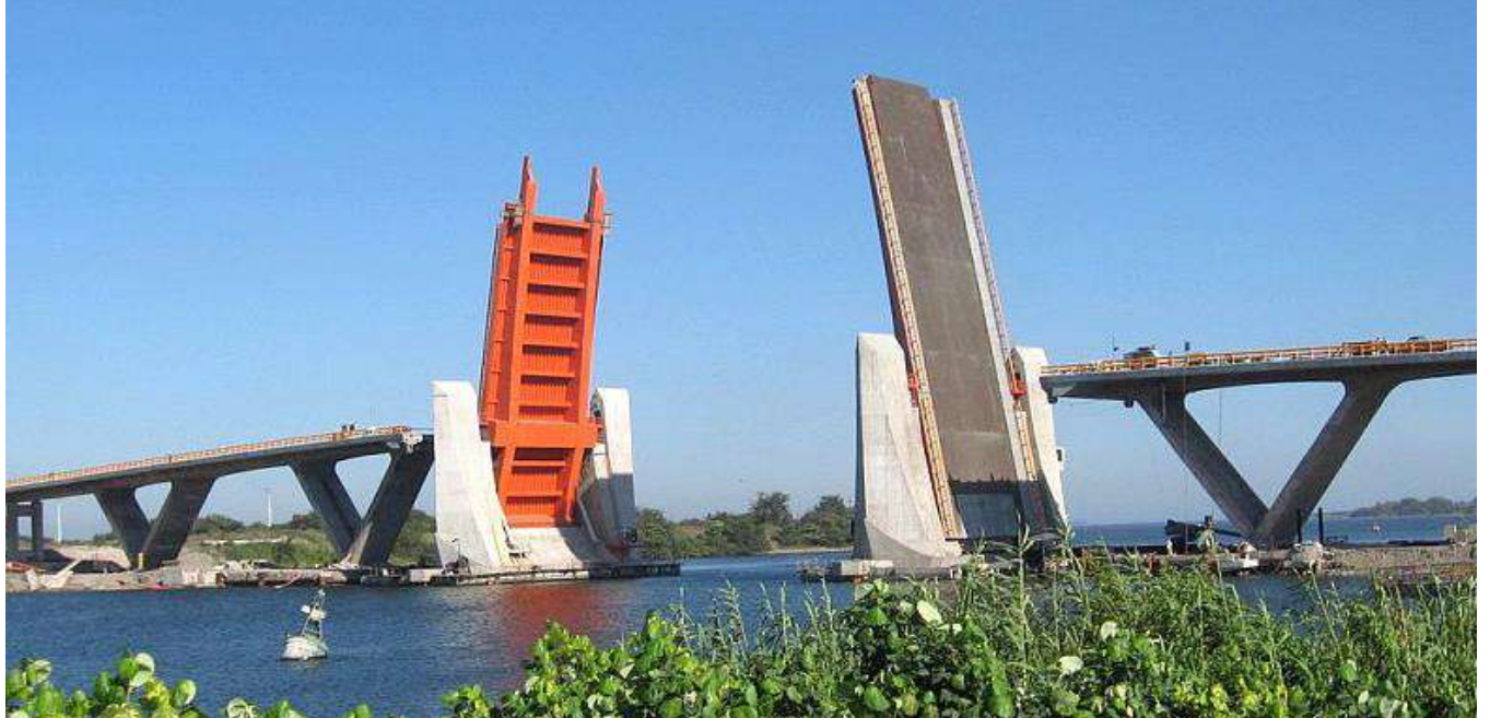
Figura 4.7 Puente Basculante Albatros operando, Lázaro Cárdenas.
