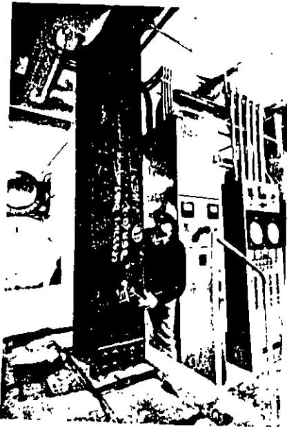
Columna pesada conectada a su placa de base por medio de soldadura y pernos de alta resistencia. (Cortesía de la Bethlehem Steel Corporation.)
