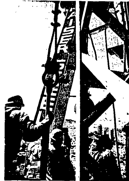
Montaje de la estructura de acero del edificio Transamerica Pyramid en San Francisco, Calif. (Cortesía de Kaiser Steel Corporation.)
