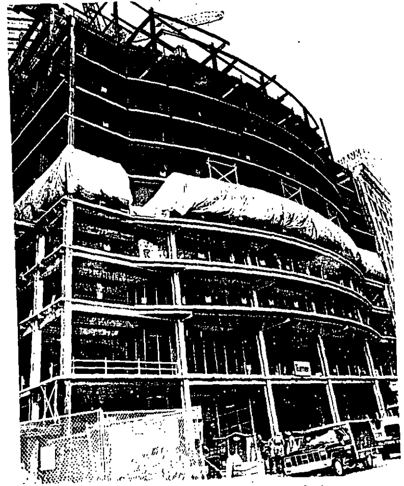
Edificio en Boston, Mass (Cortesía de la Owen Steel Company, Inc.)
