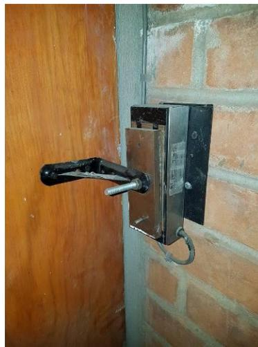
Ilustración 62 Electroimán adaptado
