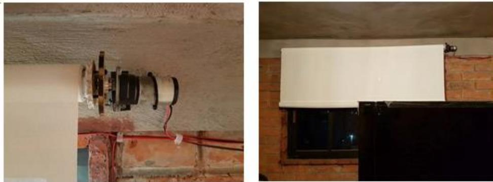
Ilustración 60 Motor acoplado a persiana
