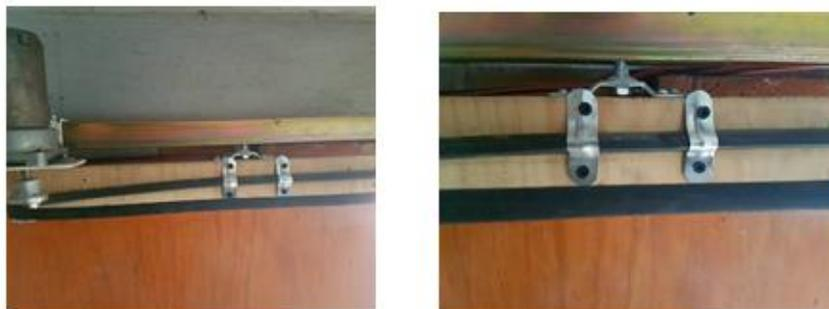
Ilustración 55 placas fijadas a la puerta junto con la banda
