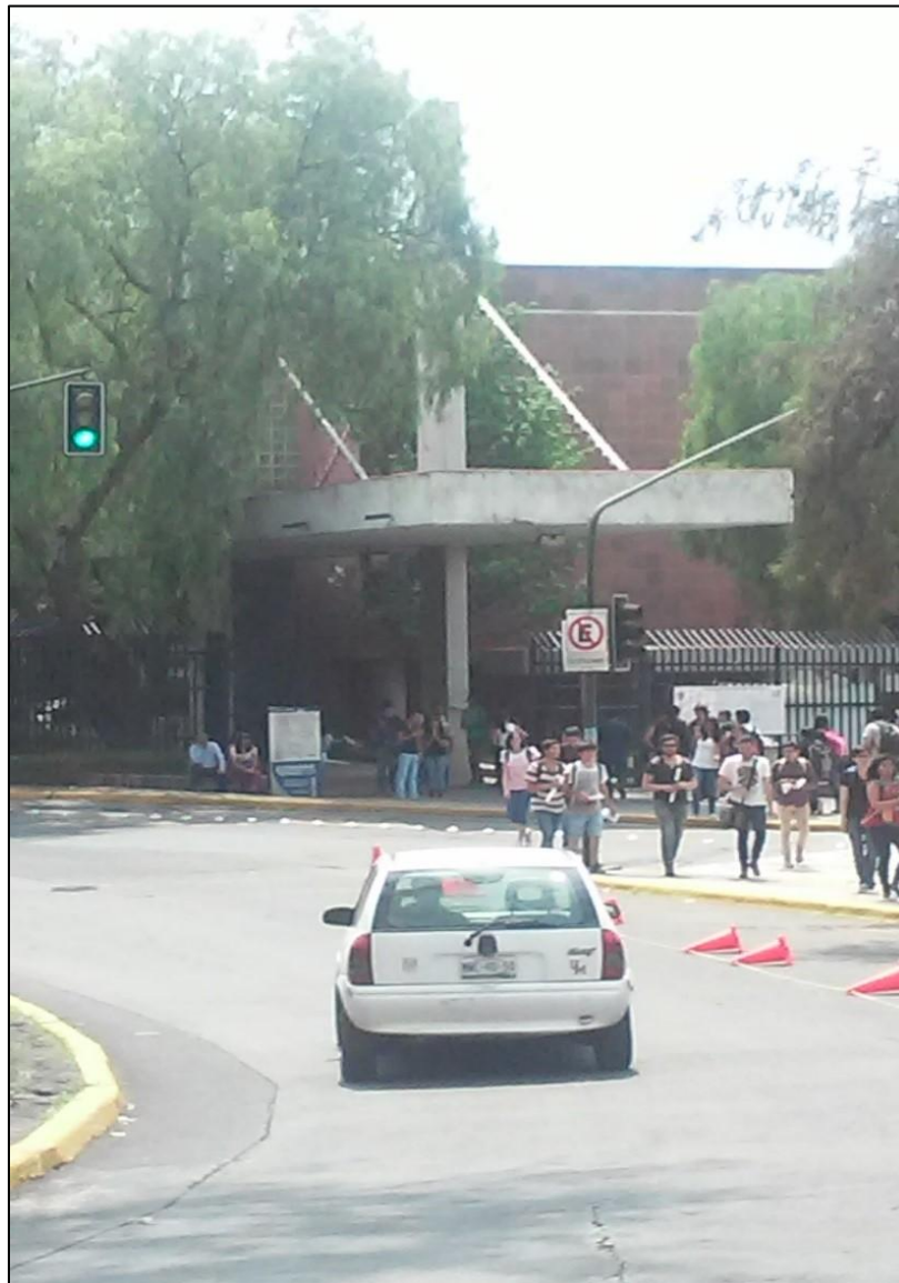
Imagen 1.1. Acceso principal del Anexo de Ingeniería y vista de la estructura atirantada
