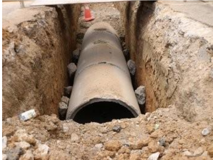
Figura 4 Colector de aguas 7
