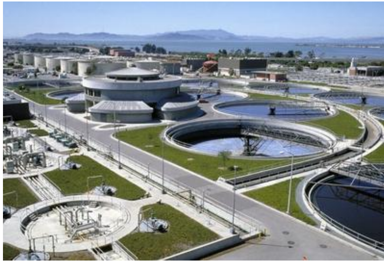
Figura 8 Planta de tratamiento de aguas residuales 11
