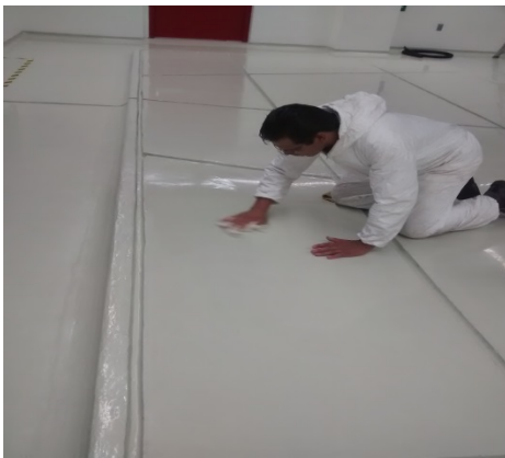
Figura 5.21. Piso epóxico área 1
