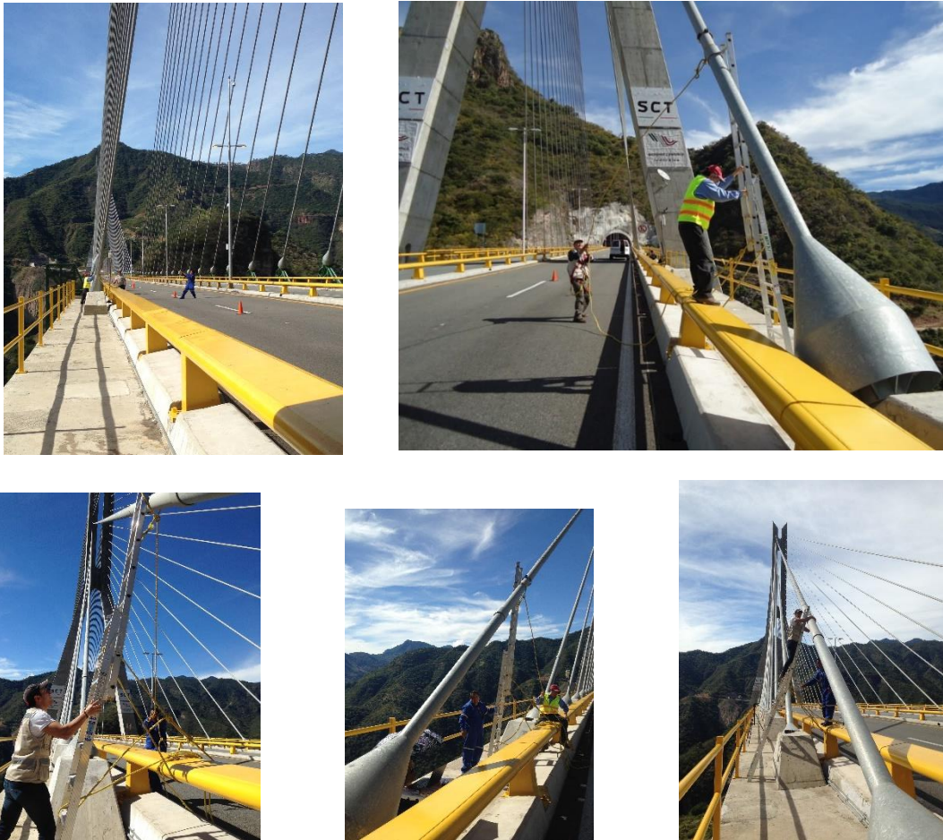
Figura 2.14 Prueba del tirón en los puentes probados
