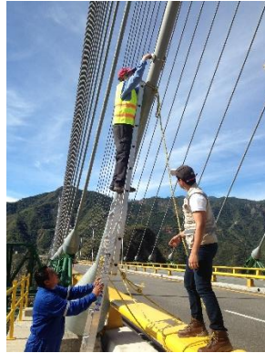
Figura 2.11 Instalación de acelerómetro en el Tirante 1 y de estación meteorológica
