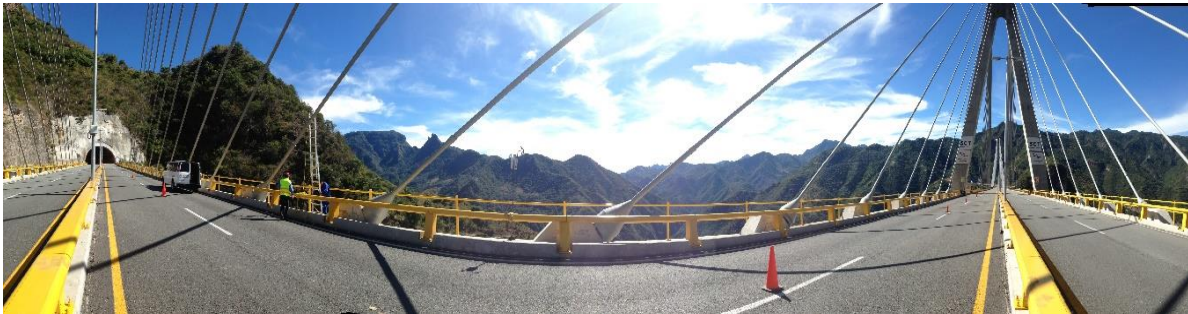
Figura 2.9. Vista panorámica de la zona de trabajo.
