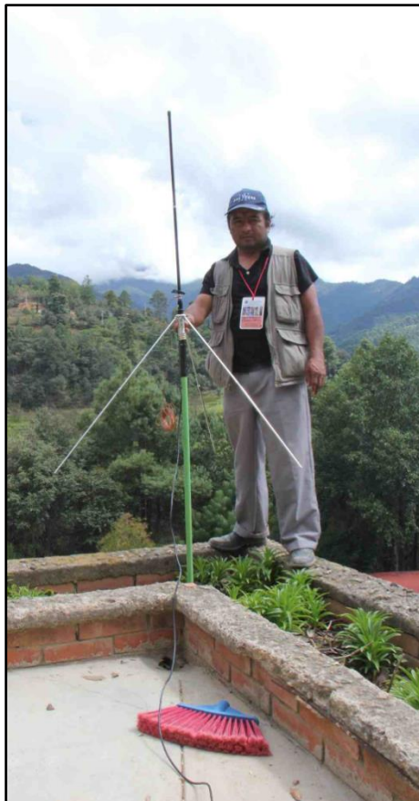
Imagen 1. Técnico instalando antena en palo de escoba.
