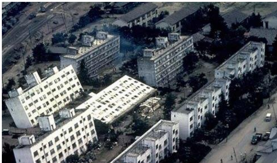
Figura 1.2 Volteo de edificios de departamento por pérdida de capacidad de carga en Niigata, Japón 1964
