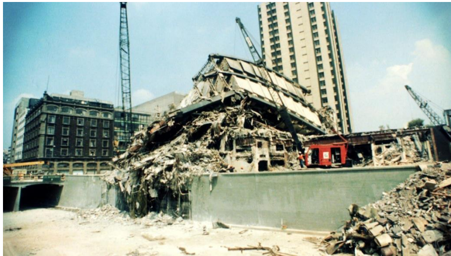
Figura 1.3 Complejo de apartamentos en Pino Suarez derrumbado, México 1985
