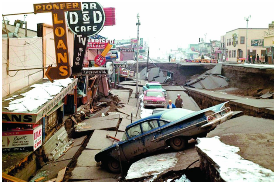
Figura 1.1 Daños provocados por la falla del suelo en Anchorage, Alaska 1964
