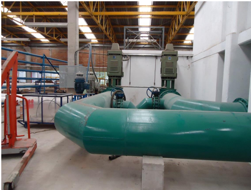
Figura 3.15 Sistema de bombas y bypass con válvulas.
